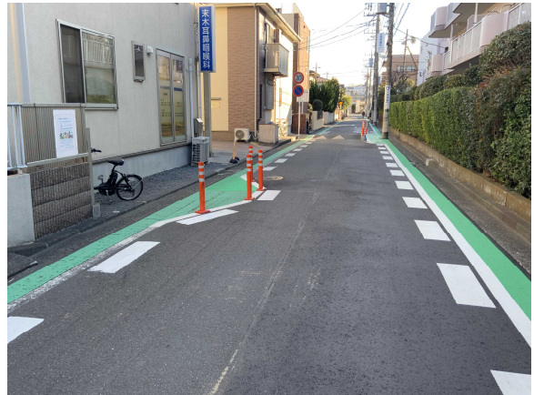
狭さくの配置によるクランク形状
