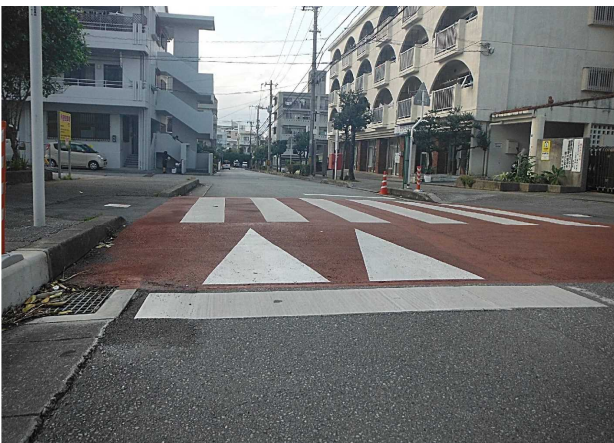
現道とのすりつけ
