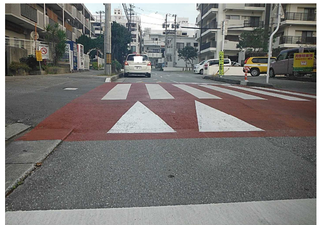
現道とのすりつけ
