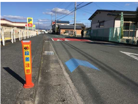
ゴム製ポールと矢羽根型の路面表示
