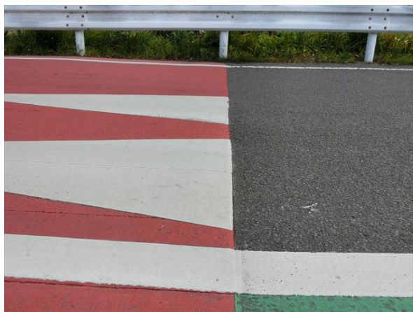
既設舗装上に設置(オーバーレイ)
