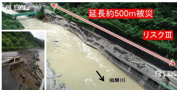
図-1 国道41号における洗掘被災の様子
