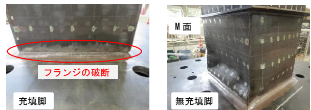
写真-2 試験後試験体状況 (M面)
