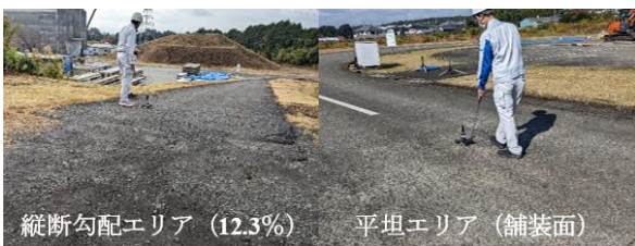
図-2 検証実験の状況
