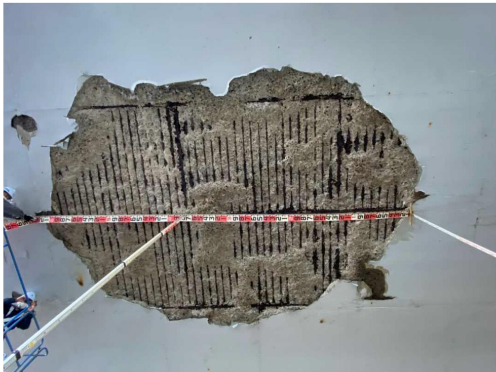
(b) コンクリート剥離状況
