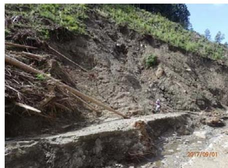
斜面下部浸水による急傾斜地崩壊
