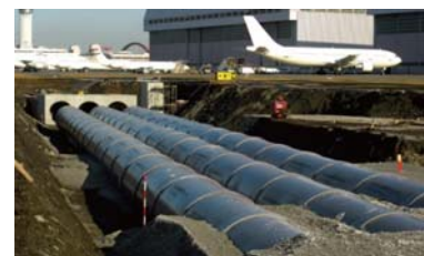
管渠の施工例
