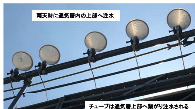
注水用漏斗とチューブの設置
