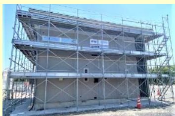
共同研究締結先の木造住宅実験棟
