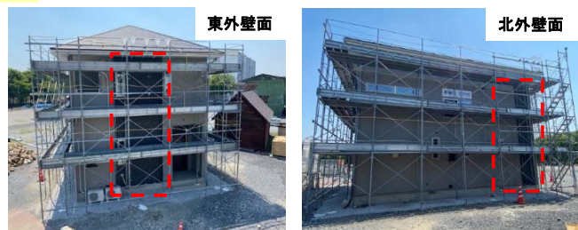
実大木造住宅実験棟の測定対象外壁
