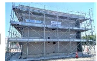
実大木造住宅実験棟
