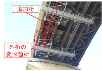
写真-1 5主鋼非合成I桁橋の事例
