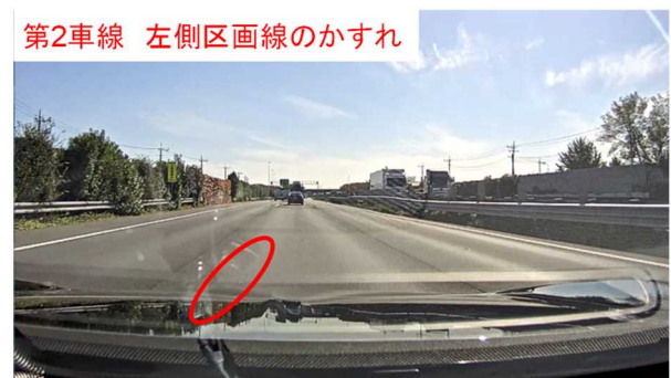
図-5 車載カメラが検知できなかった箇所例
