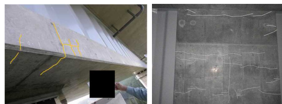
写真-2 鋼・コンクリート接合部、橋脚柱頭部のひび割れ事例
