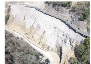
図-1 戸下大橋下側斜面
