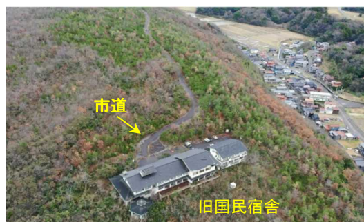
図-1 現場飛行実験場所（片野町市道）
