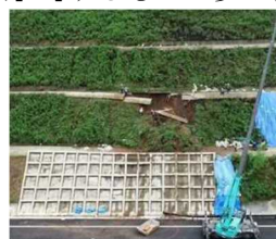
写真-1 長大切土崩壊 写真-2 長大盛土崩壊
