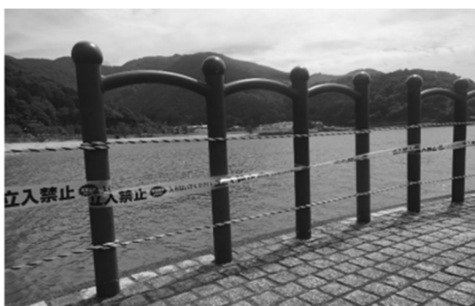
トラロープによる隙間処理（横棧形式）
