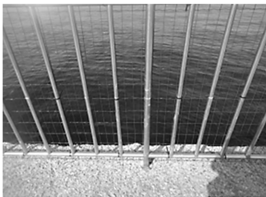
ネットによる隙間処理（縦棧形式）
