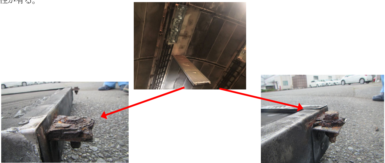
写真-付4 吸音板パネル取付部プレート破断状況（出典：近畿地方整備局提供資料）
