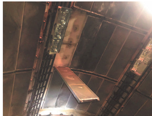
写真-付3 吸音板パネル垂れ下がり状況（拡大）
