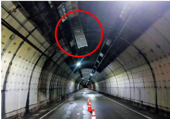
写真-付2 吸音板パネル垂れ下がり状況
