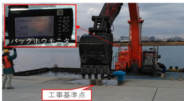
図-2.9 バケット位置精度の確認事例
