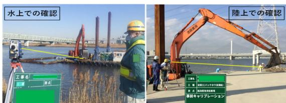
図-2.8 テスト作業による精度確認事例
