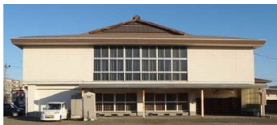
（改修前：県立高校体育館）
