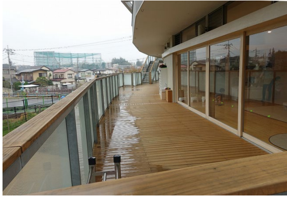
保育園内部の様子（テラス）
