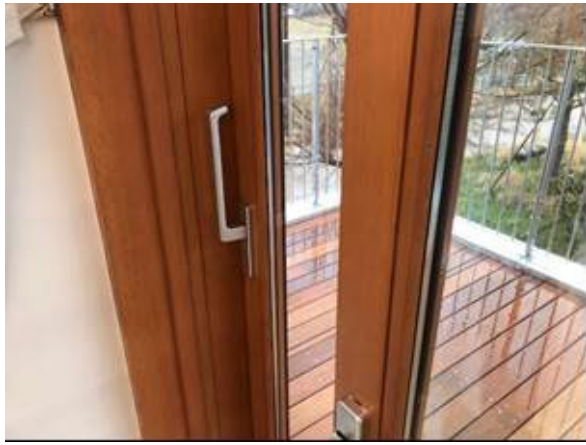
三層の防音扉
