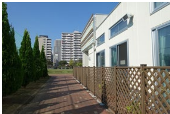
テニスコート・園路との隣接部（柵あり）
