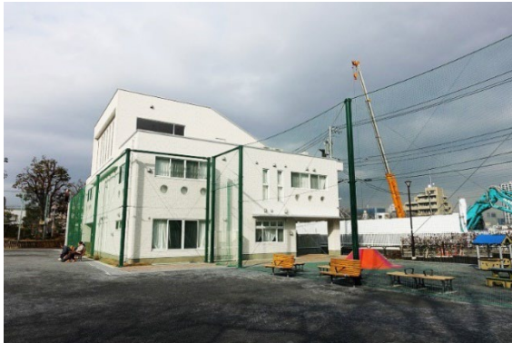
公園内広場からみた保育所
