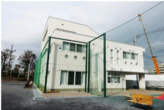
広場側には、防球ネットを設置
