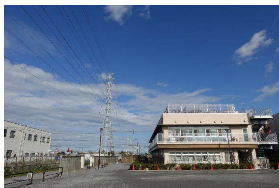
公園側からみた保育所
