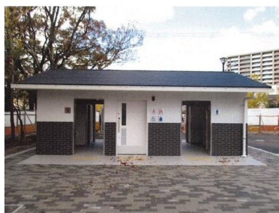
④新設されたトイレ
