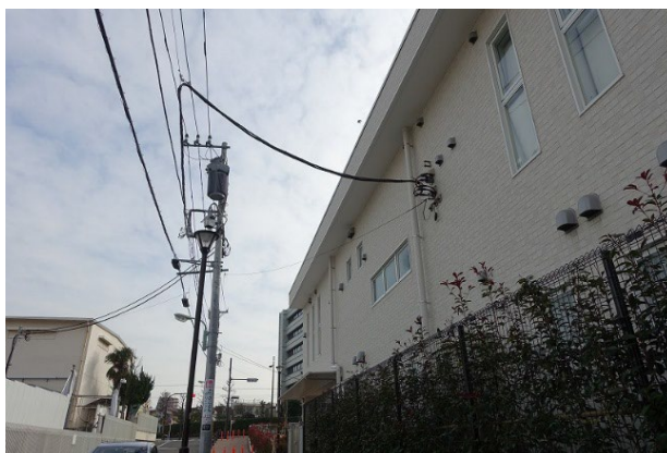
写真 5-4 公園外部からの電気の引き込み（西大井広場公園（品川区））
