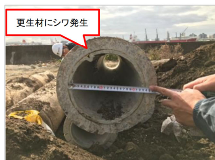
更生不良の状況
