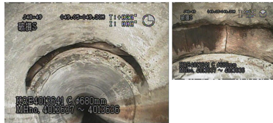
破損（欠落）の状況
