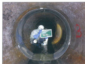
リング工法施工後写真
