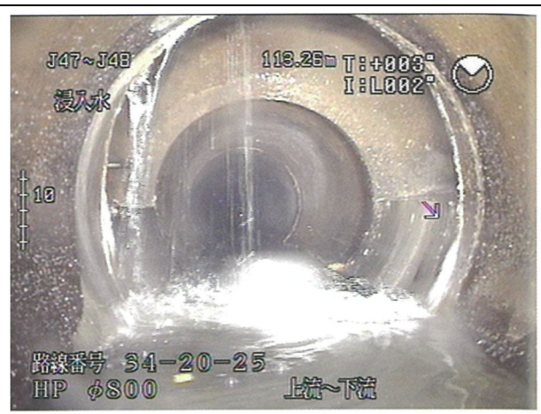
8 侵入水 (鉄筋コンクリート管の例)
