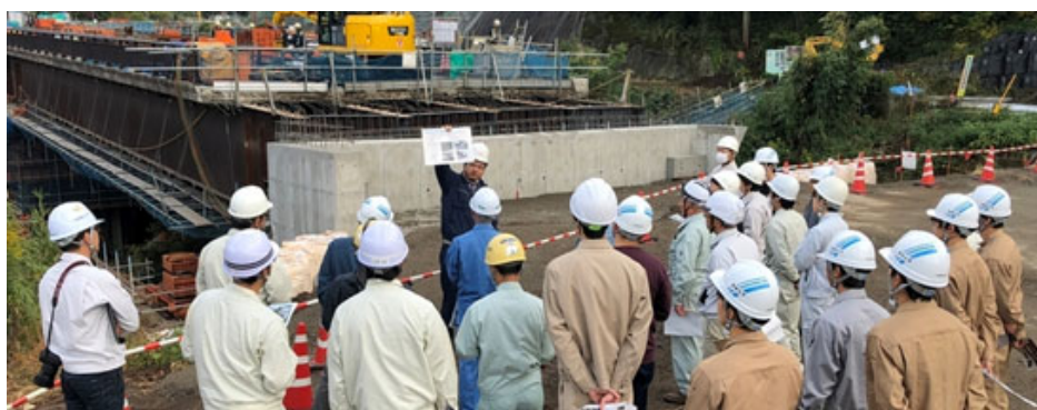
(a) 建設技術者を対象とした復旧状況の説明(俵山大橋)
