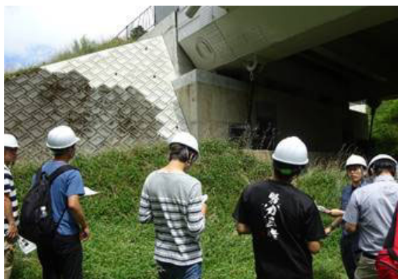
(b) 土木工学を専攻する学生を対象とした復旧状況の説明(桑鶴大橋)
