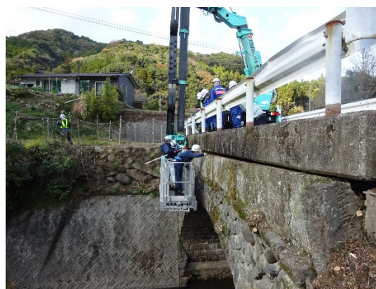
写真-5.4 大分県内の石橋の現地調査状況 (R3. 12. 3)
