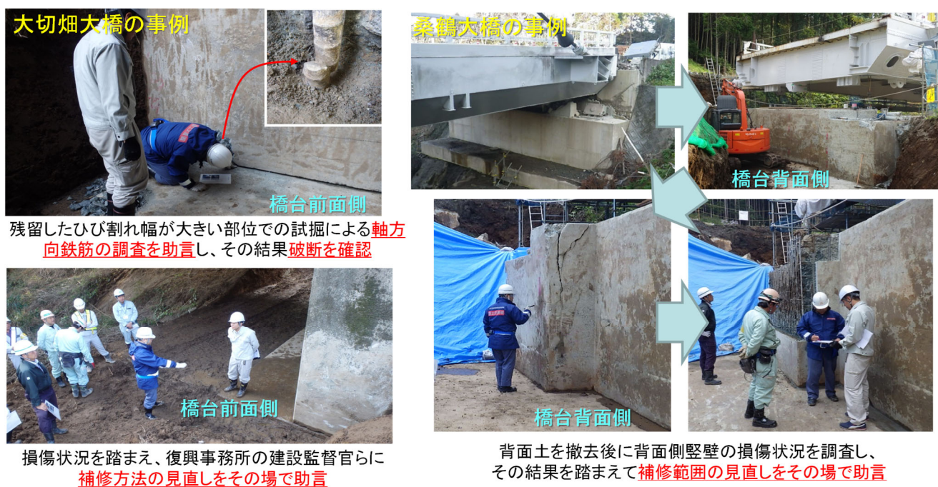
写真-3.2 道路橋の復旧現場での復旧研の技術支援状況例
