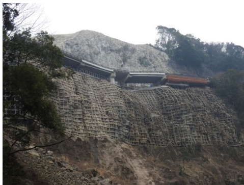
(a) 村道栃の木～立野線 戸下大橋
