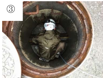
資図 2-15 FRP 製入線工具を用いた光ファイバケーブル導入状況
