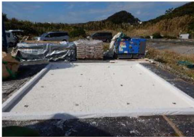
③ ピース板設置
