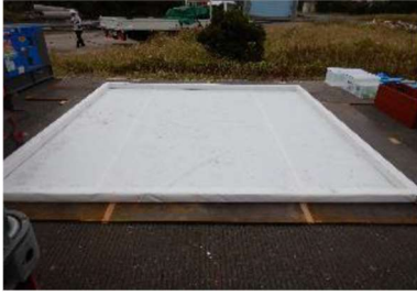
① 防災シート敷設
