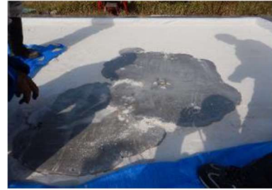
⑦ 40分養生後の樹脂確認
