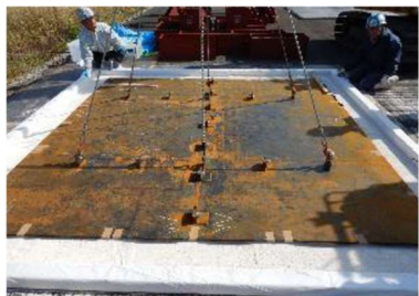
④ 鉄板敷設
