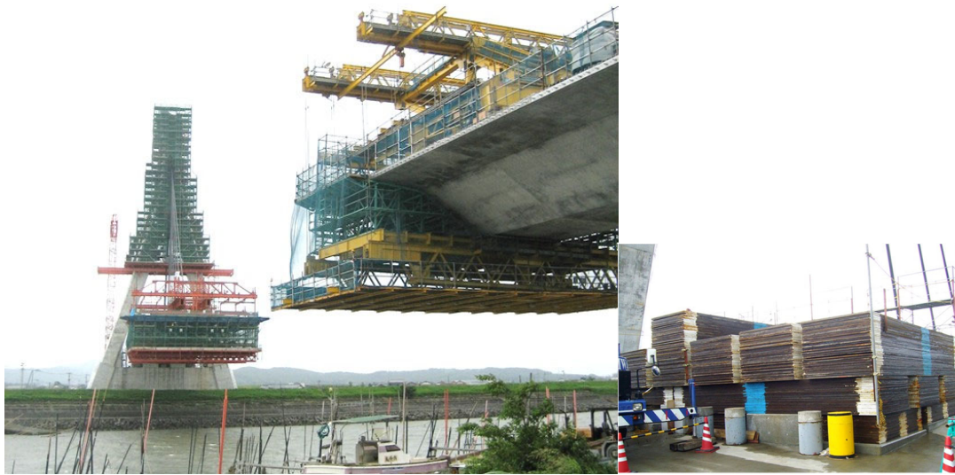
(a)施工時の状況
