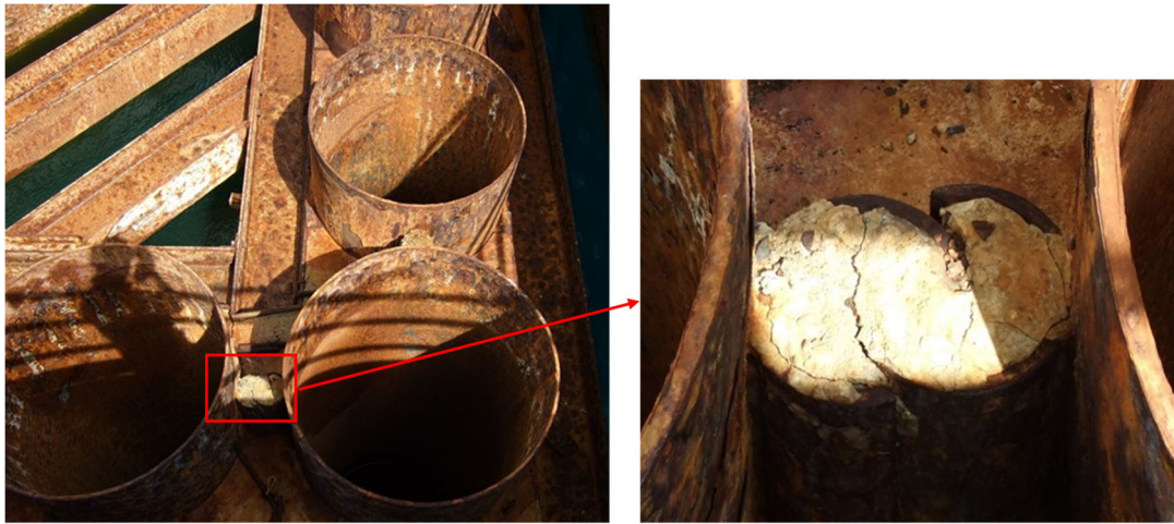
写真-3.11 鋼管矢板基礎隅角部継手管部の損傷
