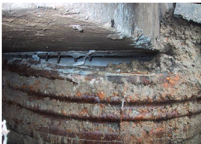
写真-3.12 2004年新潟県中越地震における深礎基礎頭部の損傷（山辺橋） 81)
