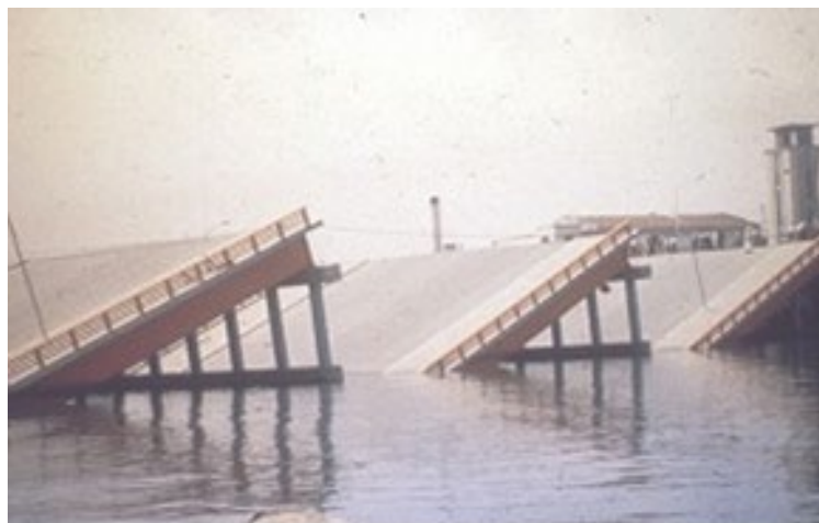
写真-3.3 1964年新潟地震における昭和大橋の被害
