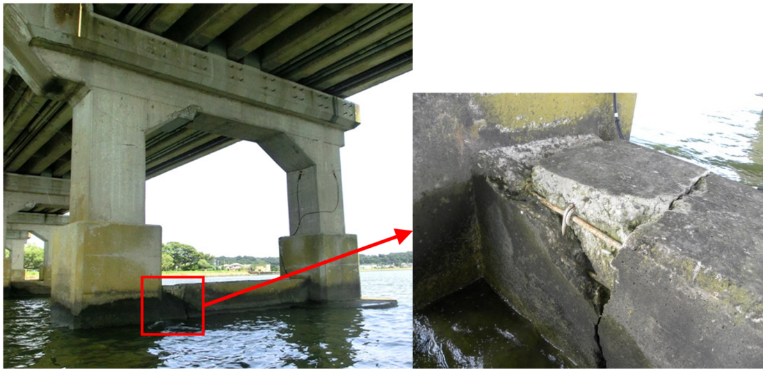
写真-3.8 ケーソン基礎に支持された橋脚の損傷 51)
