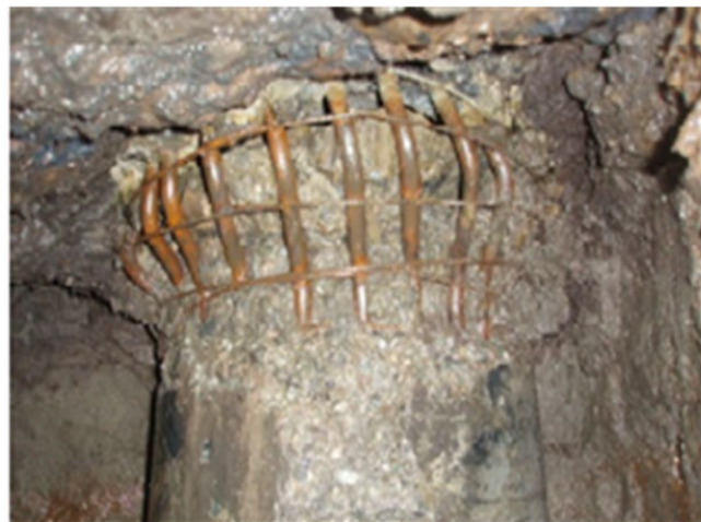
写真-3.7 2011年東北地方太平洋沖地震における既製コンクリート杭のせん断破壊（西川橋） 51)
