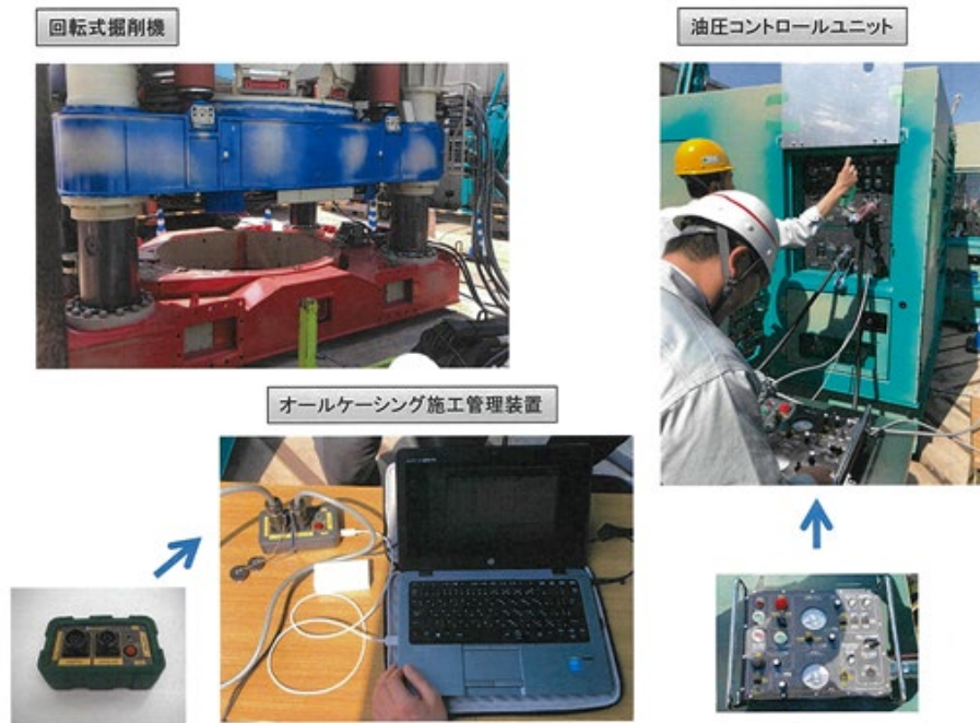
図-3.13 場所打ち杭オールケーシング工法施工管理装置の概要 45)
