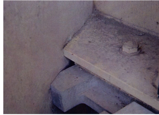
(b) 桁とパラペットの衝突
