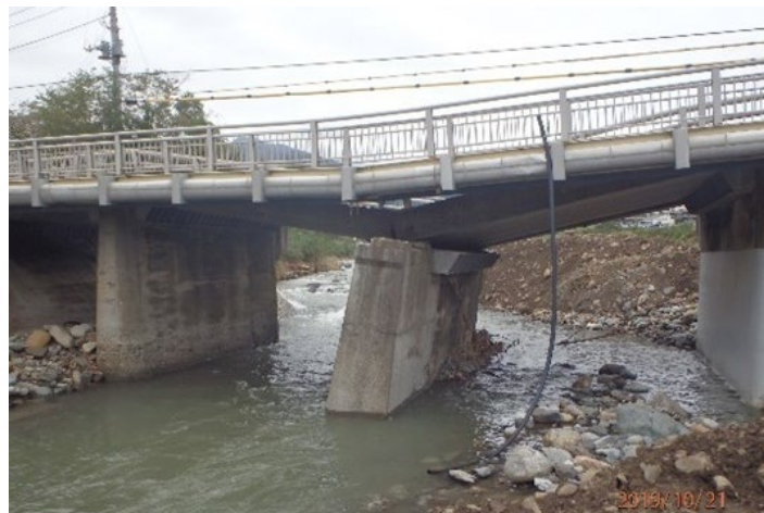
写真-3.4 洗掘による橋脚の沈下・傾斜（法雲寺橋） 33)
