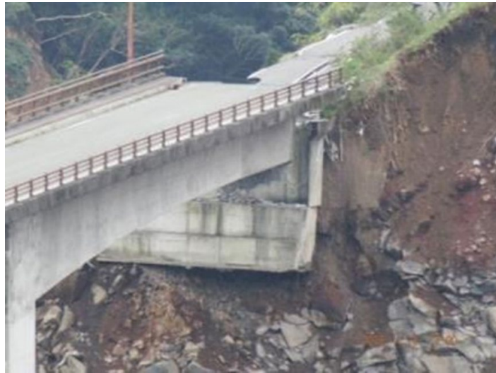
写真-3.2 地震時の斜面崩壊により沈下した橋台（阿蘇長陽大橋） 25)
