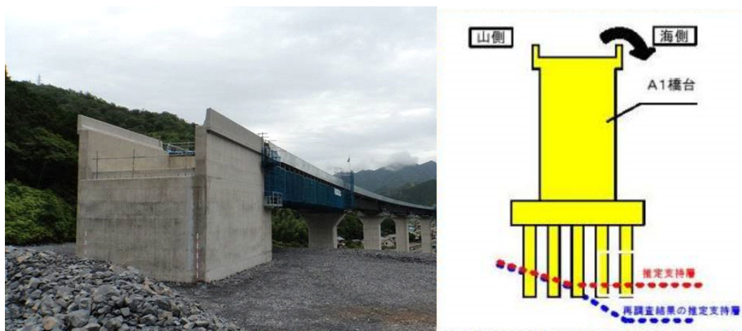
図-3.12 施工中に傾斜が生じた橋台 44)
