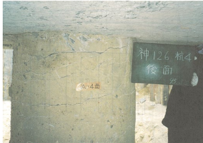
写真-3.6 1995年兵庫県南部地震における場所打ち杭の損傷例 28)
