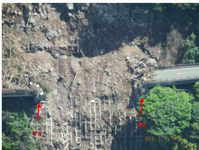
写真-3.13 2016年熊本地震における橋脚の崩落（戸下大橋） 25)
