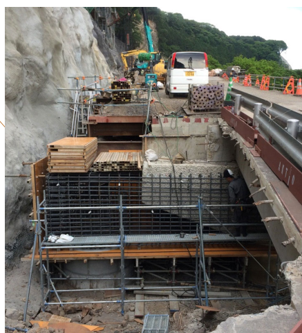
図-3.34 戸下大橋下部構造の復旧構造 83)
