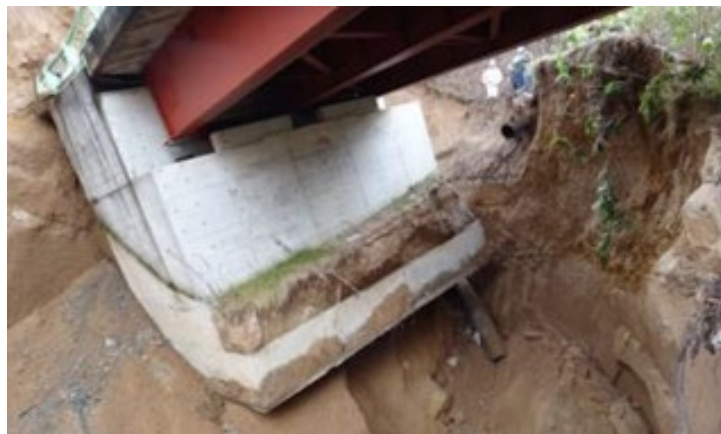
写真-3.1 斜面上に設置された橋台の崩落（伏見橋） 24)
