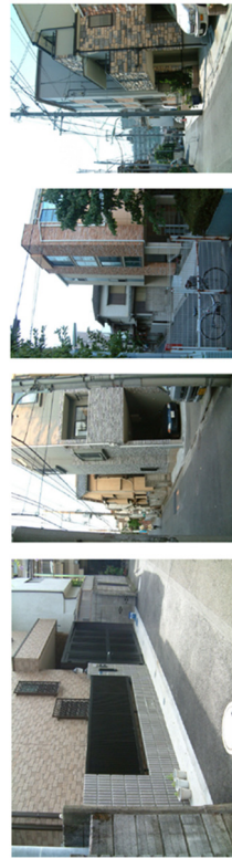
街並み誘導型地区計画の認定を受けて建て替わった建物 (出典) 密集市街地整備のための集団規定の運用ガイドブック
