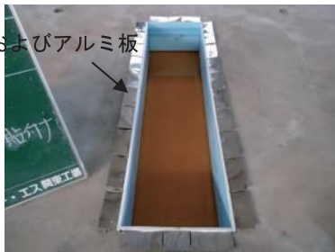
③発泡型枠の設置
