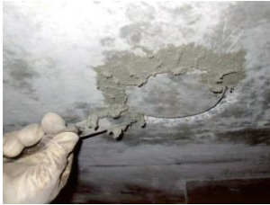
⑧断面修復材充填 左官作業
