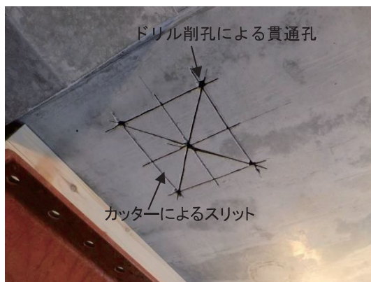
写真 2 漏水検知試験用スリットの作製状況
