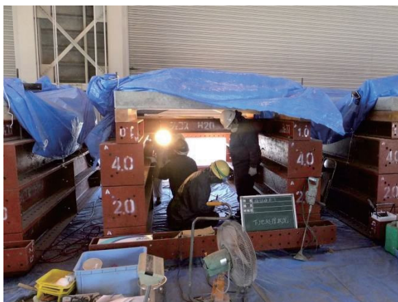
(a) 施工状況（架台設置）
