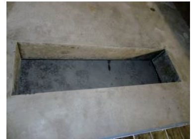
②箱抜き型枠の撤去
