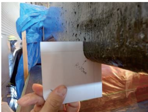
(a) 角部面取り状況
