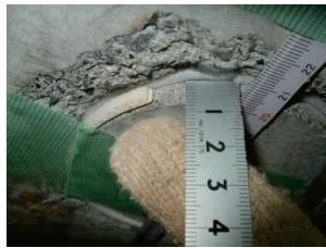
⑦離隔調整材設置位置計測 底面より5mm確保
