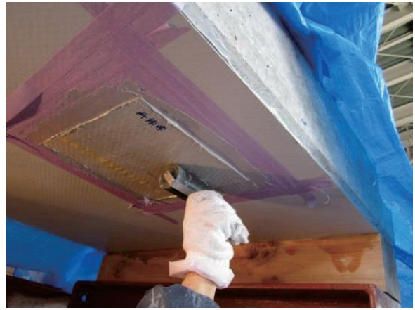
(b) 切り欠き部に対する施工(補修)
