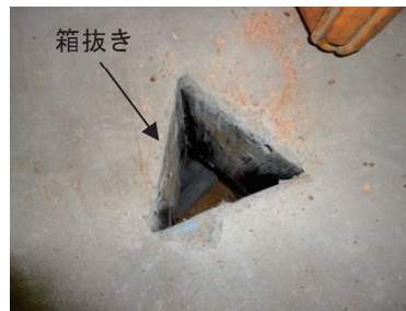
②箱抜き型枠の撤去
