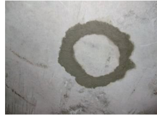
⑨断面修復材充填完了
