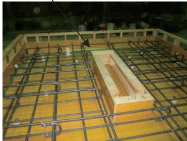
①箱抜き型枠の設置
