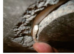
⑥離隔調整材設置位置調整
