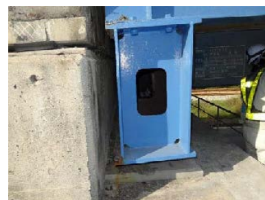
(i) 桁端部の点検開口部
