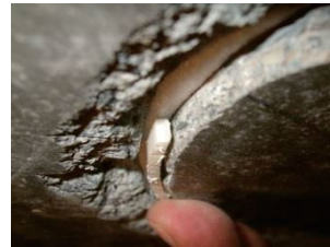
⑥離隔調整材設置位置調整
