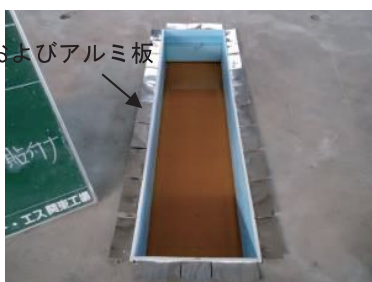
③発泡型枠の設置
