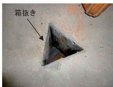
②箱抜き型枠の撤去
