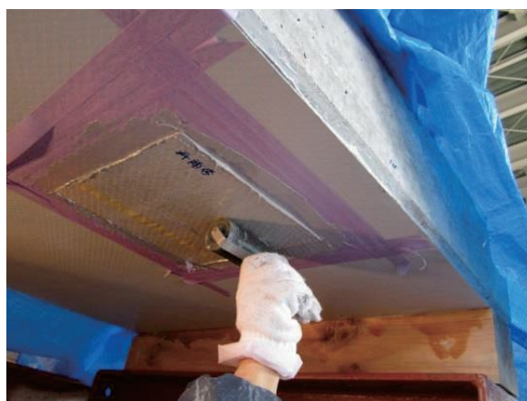
(b) 切り欠き部に対する施工(補修)
