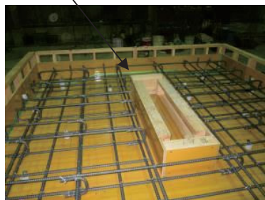
①箱抜き型枠の設置
