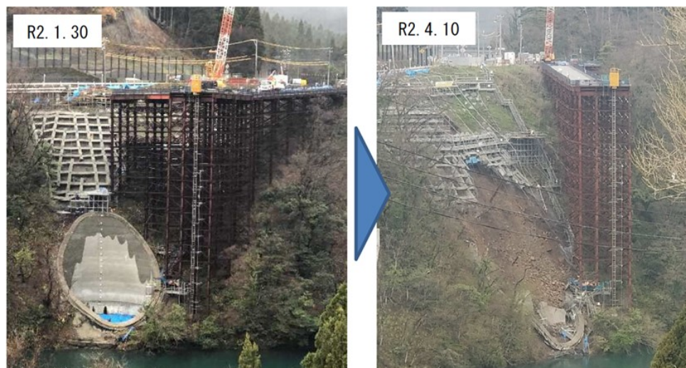
竹割り工崩壊の状況
