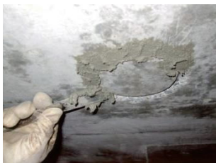
⑧断面修復材充填 左官作業
