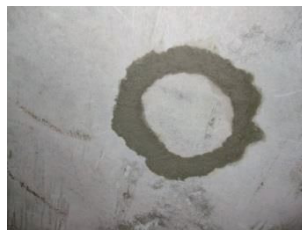
⑨断面修復材充填完了
