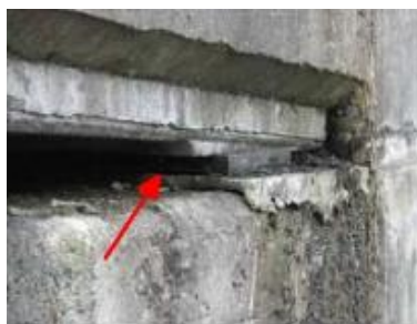
(b) 桁下面と橋座の離隔が狭い
