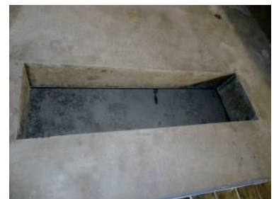
②箱抜き型枠の撤去
