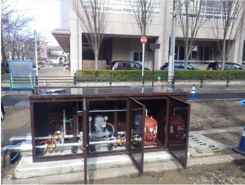
写真 V-5 制御盤一体型バルブボックス写真
