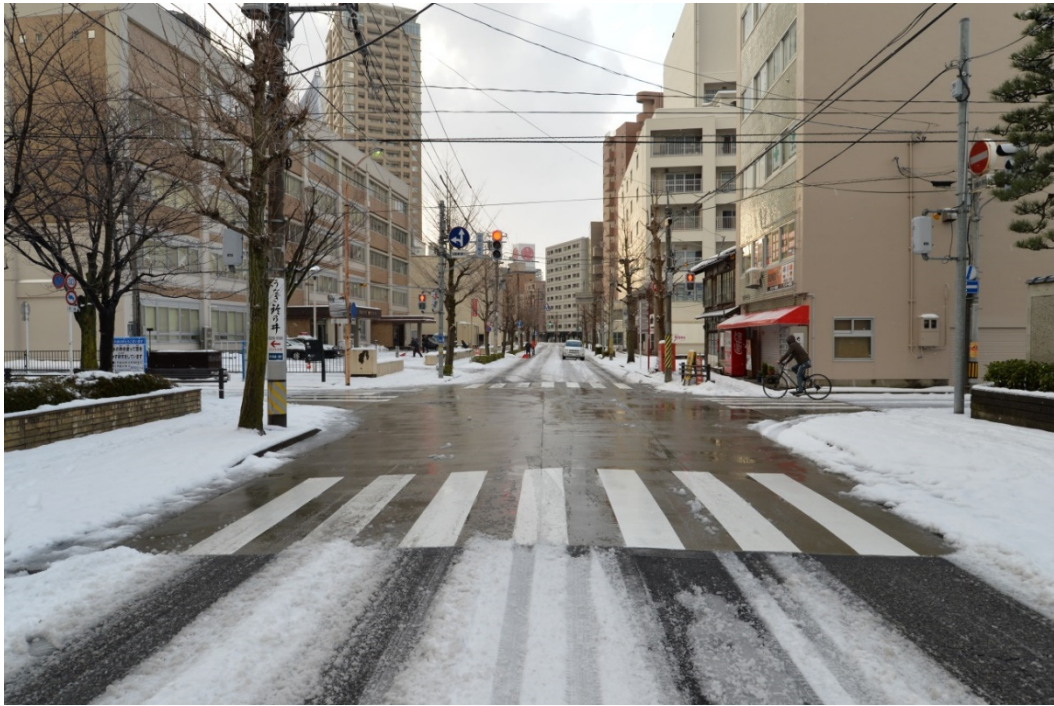
写真 V-6 実証研究施設の融雪状況
