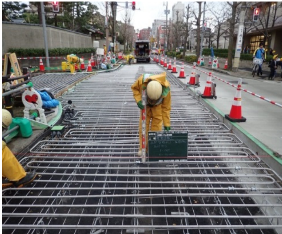
写真 V-2 放熱パネル※コンクリート打設前
