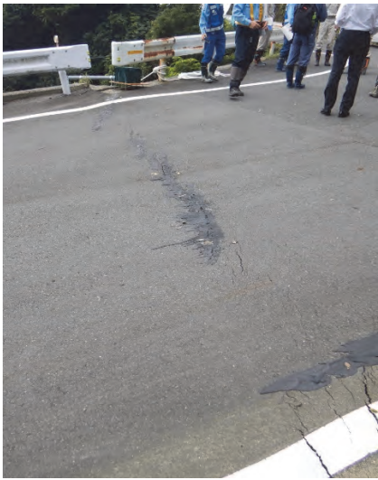
写真-4.3.2 擁壁南側直上の雁行亀裂 (7月27日撮影)
