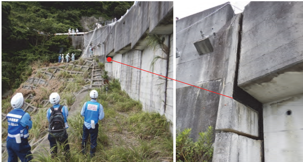
写真-4.3.5 擁壁端部の段差と目開き (7月27日撮影)
