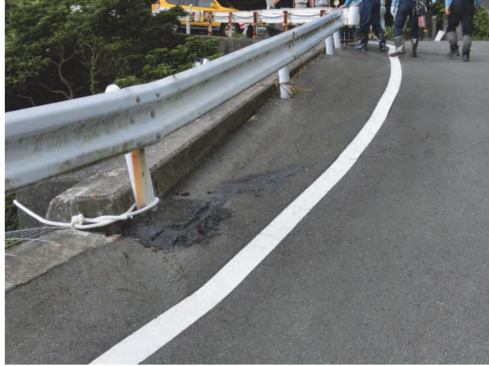
写真-4.3.3 擁壁北側直上の陥没 (7月27日撮影)
