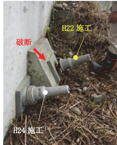
写真-4.3.4 アンカーの破断状況 (7月27日撮影)
