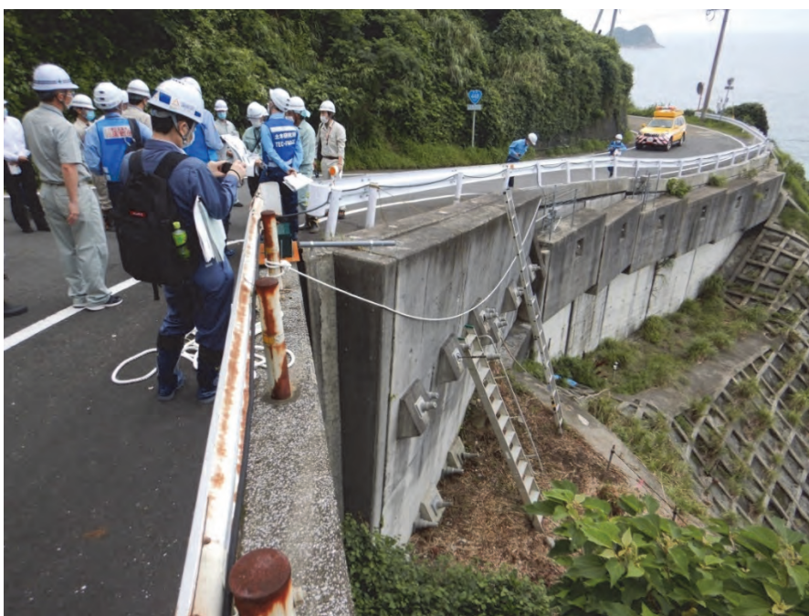
写真-4.3.1 擁壁の傾倒状況（7月27日撮影）
