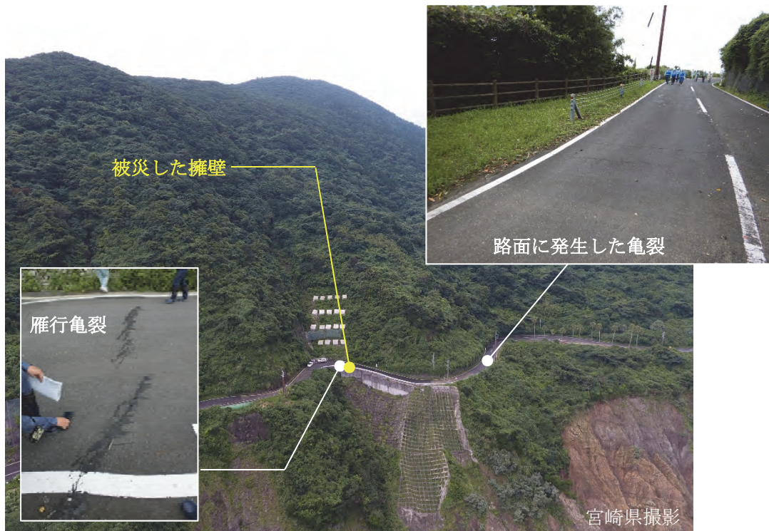
写真-4.3.6 路面に発生した亀裂 (7月27日撮影)
