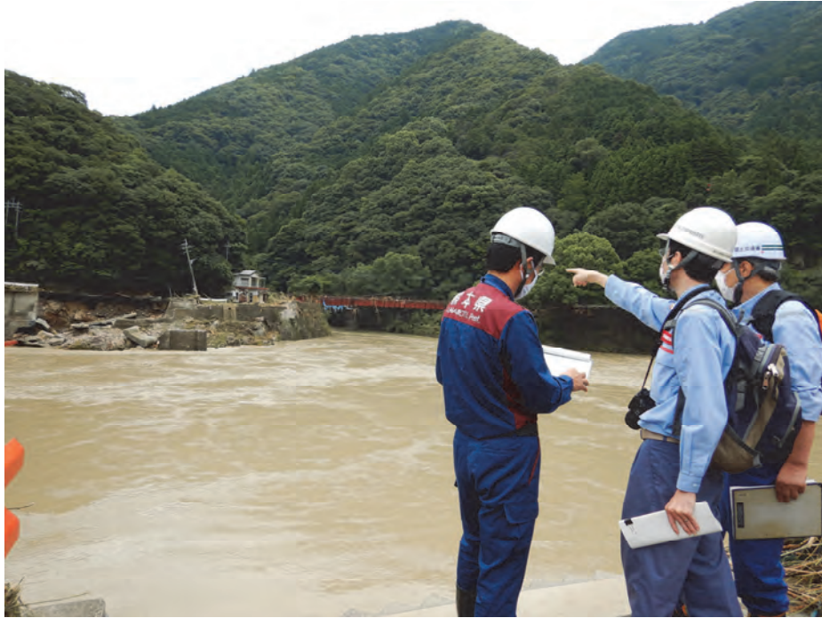
写真-2.1.1 熊本県八代市での調査状況（深水橋）
