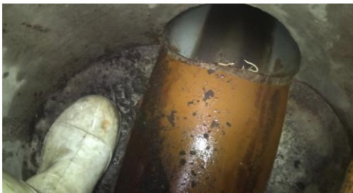
図 2-17 点検直視型カメラによる異常写真例（塩ビ管）
