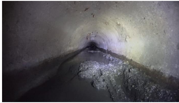
図 2-21 本フィールドにおける土砂等堆積（走行不能の一例）
