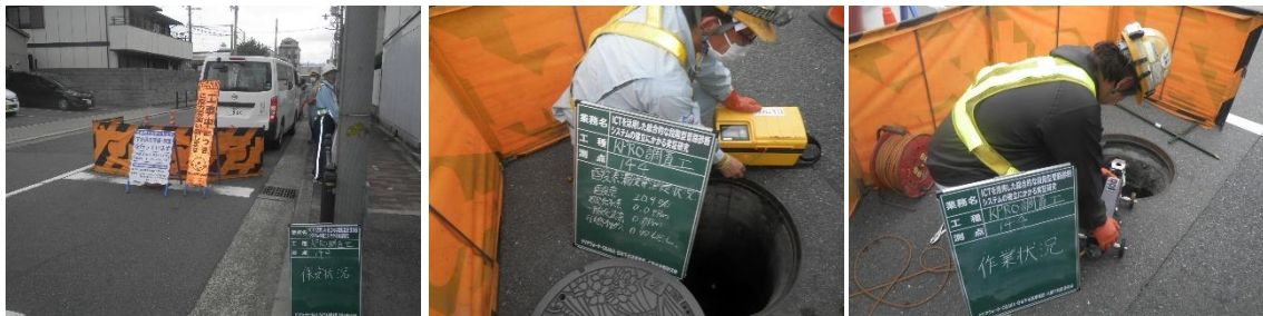
図 2-13 点検直視型カメラの調査手順
