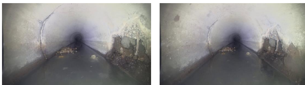
図 2-5 抽出不能となったコンクリート管の状況写真例
