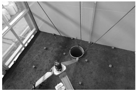
写真8 地盤高の計測
