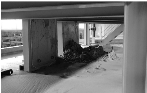
写真7 土砂流出扉解放状況
