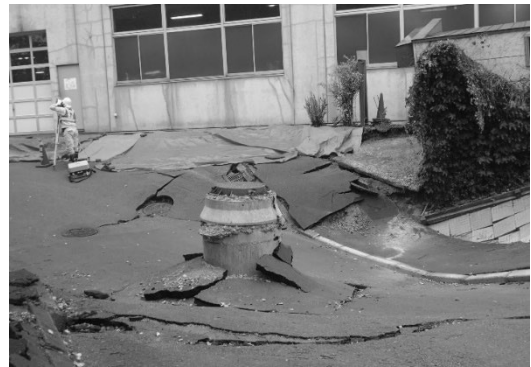
写真2 マンホール周辺の道路陥没
