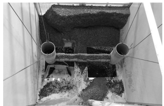
写真12 実験2 実験終了後(地盤面状況)
