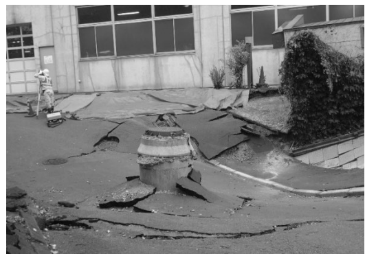
写真2 マンホール周辺の道路陥没
