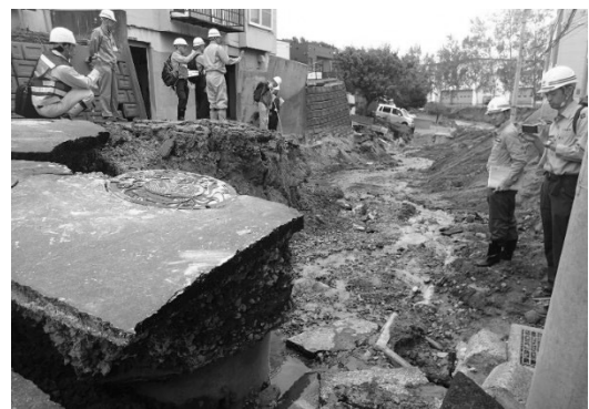
写真1 下水道管路施設と道路の崩壊
