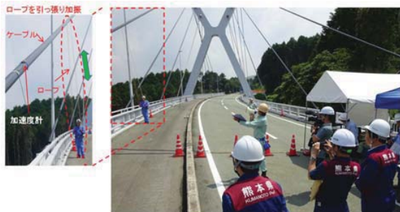
写真 ケーブル張力の確認試験状況
