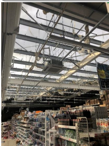
平成30年台風第21号と令和元年台風第15号の 強風による屋根ふき材の被害例
