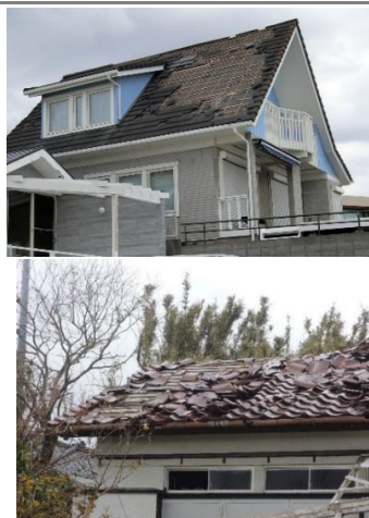
平成30年台風第21号と令和元年台風第15号の 強風による屋根ふき材の被害例
