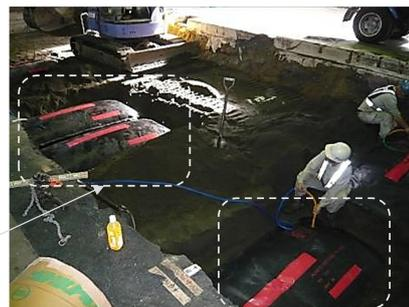
空洞を有するアスファルト試験舗装
