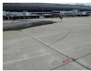
仙台空港のエプロン(コンクリート舗装)の液状化による局所沈下
