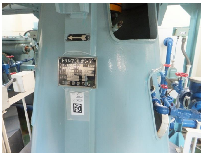
図資 2-1 管理対象へ AR タグの取付状況の例
