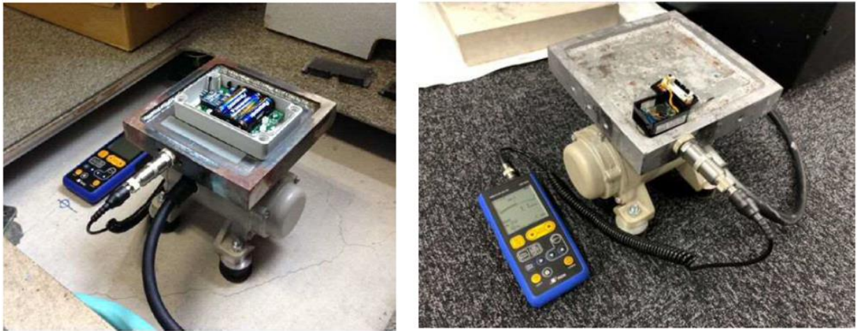
図_資 3-10 センサー測定値確認状況例
