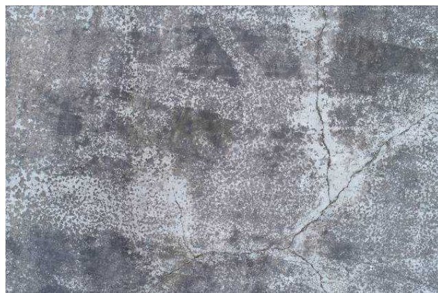
図-B.6 下崎北防波堤（近接）
