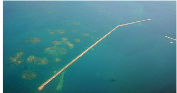
図-3.10 平良港下崎西防波堤（UAVによる空撮）
