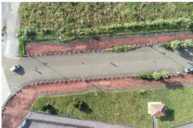
図-B.1 臨港道路マリーナ線（全景）
