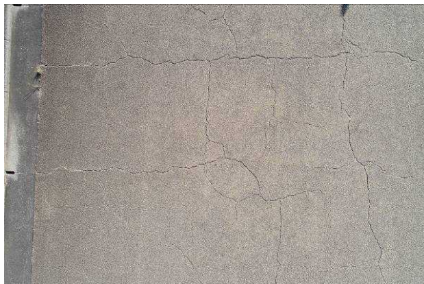
図-B.2 臨港道路マリーナ線（近接）
