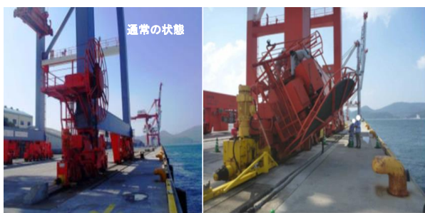
(a) 通常の状態 (b) 損傷後の状態
