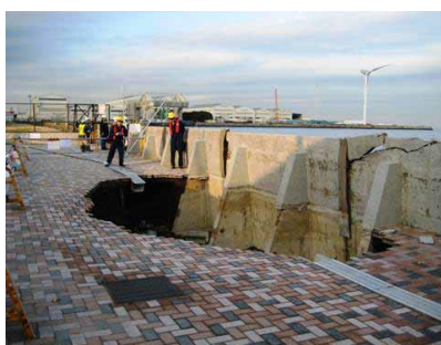
(d) 重力式護岸の損傷（前面壁の損傷及び背後地盤の吸出し）
