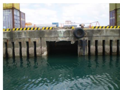
(c) スリット構造の損傷
