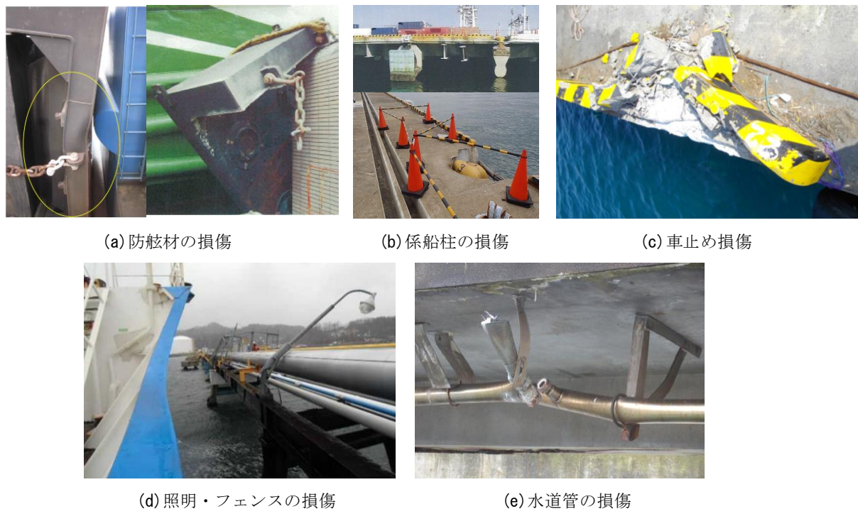
写真-3.2 付帯設備の代表的な損傷事例 1)
