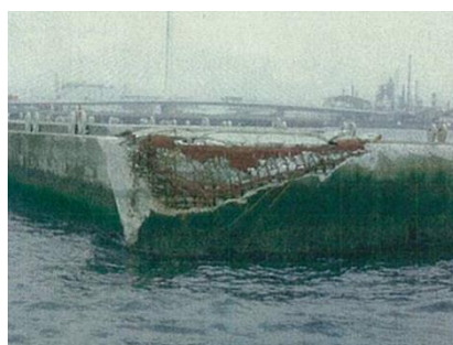
(b) ケーソン（重力式岸壁）の損傷
