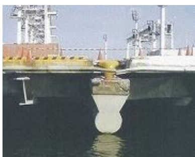
(a) 栈橋の鋼管杭の損傷
