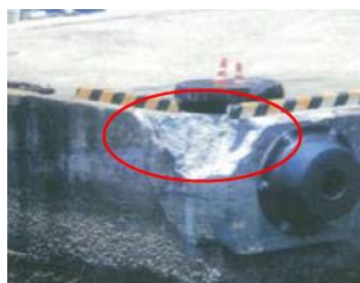
(e) ケーソン（重力式岸壁）の損傷
