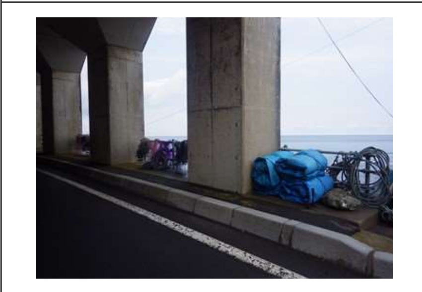
写真番号 S-12.1.2 説明 防護柵や歩道に資材(ロープ・網など)による不法占拠が見られた例。
