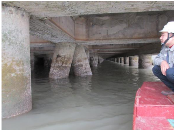
(b)栈橋下面部の点検の様子
