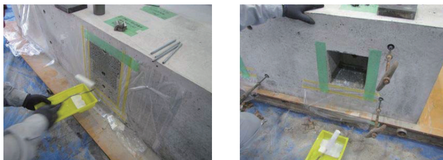
写真 3-2 吸水調整剤塗布状況
