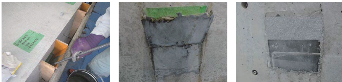
写真 3-1 コンクリート投入口処理状況
