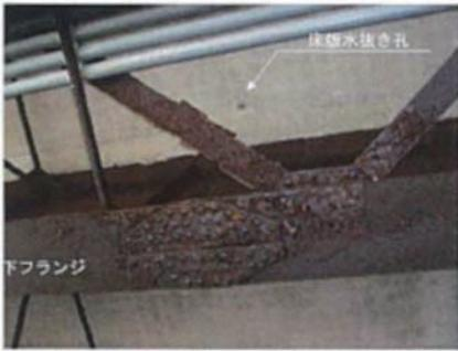
写真-1 床版水抜き孔の影響により層状錆が発生した耐候性鋼材の例
