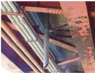
写真-3 下フランジ損傷例
