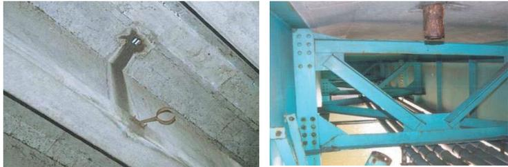
図-2 支持金具の不具合による排水管の脱落
