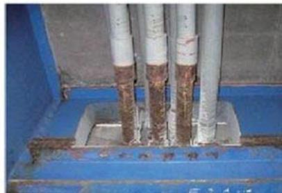
写真-3 添架物の鋼部材の腐食
