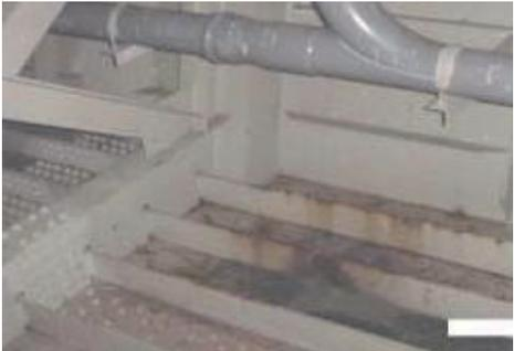
写真-2 箱桁内滞水の例
