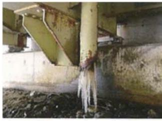
写真-4 排水管流末処理の不良事例
