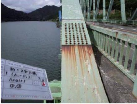
写真-2 連結板周辺の腐食事例
