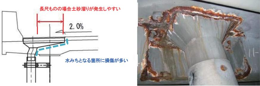
図-1 排水柵周辺の損傷状況
