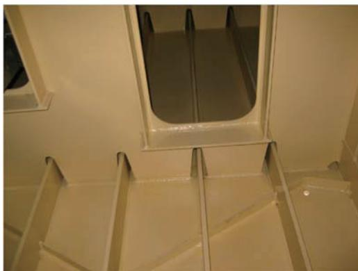
写真-1 箱桁内導水の例
