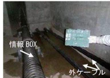
写真-4 添架物による箱桁内部の排水
