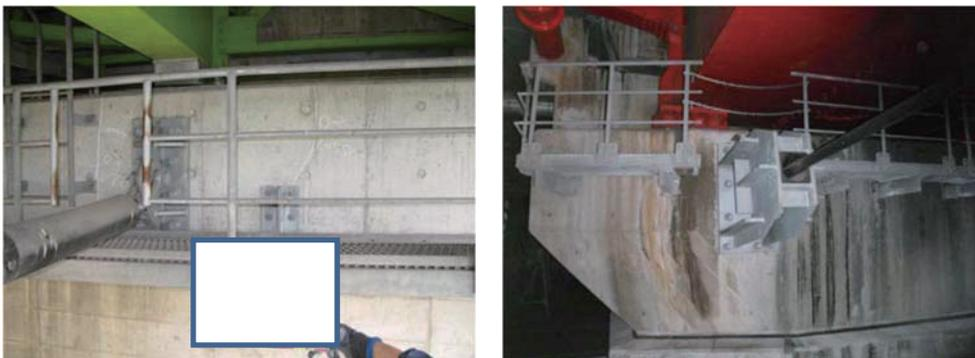
写真-5.2.5 検査路と落橋防止装置との取合い
