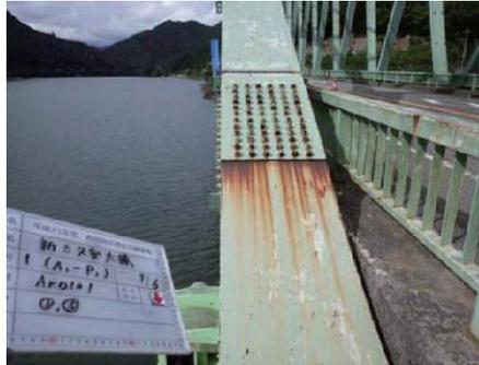
写真-5.2.11 連結板周辺の腐食事例
