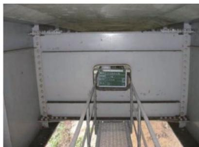
写真-5.2.1 開口の小さい横桁
