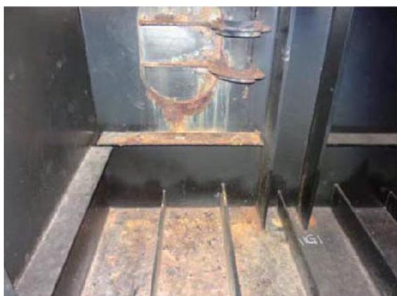
写真-5.2.7 マンホールからの漏水による腐食事例
