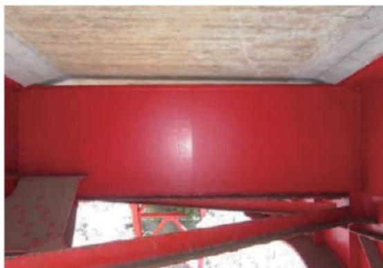
写真-5.2.3 横桁と床版のクリアランスが小さい事例
