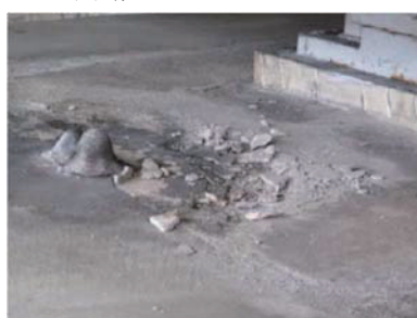
(e) 橋座面の滞水による剥離
