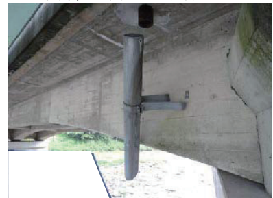
(l) 排水管の脱落
