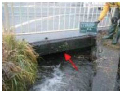
(d) 狭隘な桁下空間
