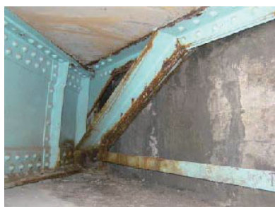
(a) 胸壁の漏水跡
