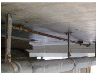
(b) 取付金具の腐食
