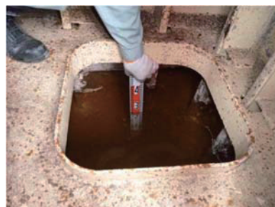
(f) 鋼製橋脚内の滞水(約 0.2m)
