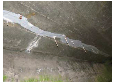
(f) 床版補修跡から遊離石灰
