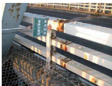
(d) 防護柵の棧の隙間の腐食
