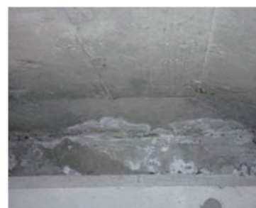
(b) A1 堅壁前面の漏水
