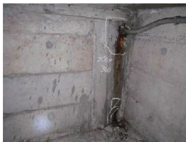
(h) 排水管の漏水
