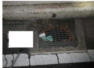
(i) 集水枡の土砂詰まり
