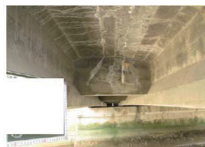
(e) 主桁と床版の取り合い部
