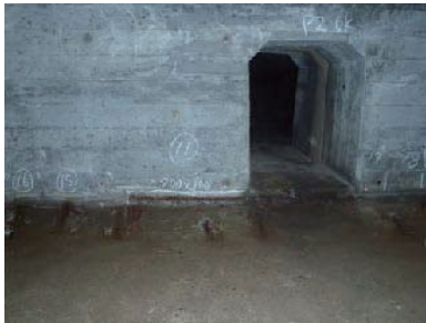
(d) 下面の剥離・鉄筋露出
