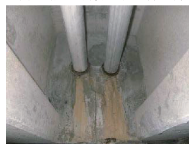
(h) 添架物の接続部からの漏水
