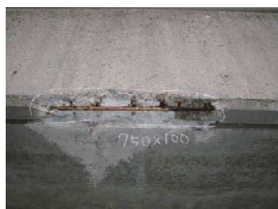
(d) 床版と地覆下面の取り合い部
