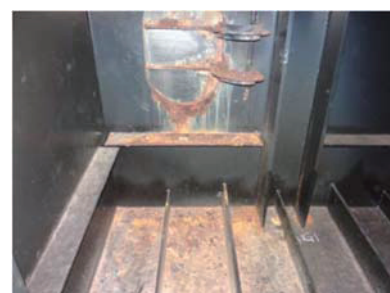
(c) マンホールからの漏水
