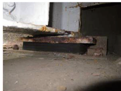
(b) G1桁の支承本体・アンカーボルトの腐食*
