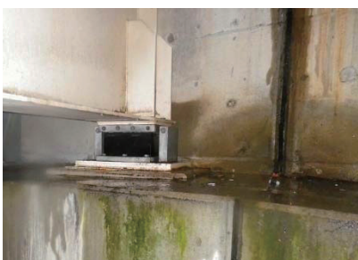
(d) 橋座面の滞水
