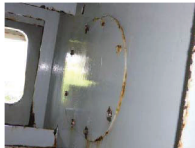
(h) マンホールが重い・小さい
