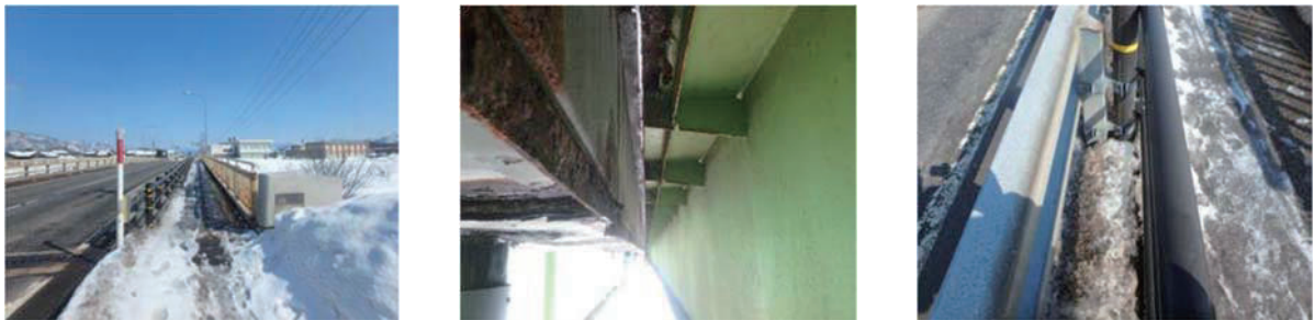
(a) 橋面全景 (b) 道路橋(左)との隙間(桁下) (c) 道路橋(左)との境界(橋面)
