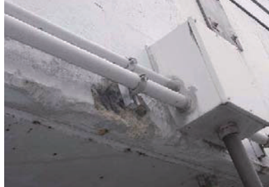
(e) 取り付け金具個所の剥落
