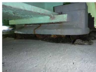
(e) 沓座モルタルの欠損
