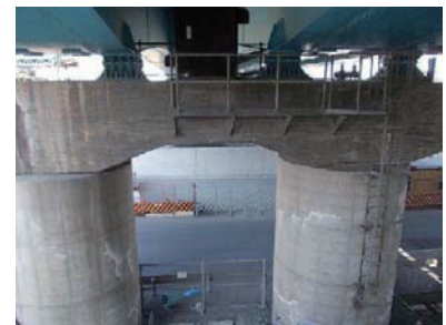
(c) 横断検査路の不足
