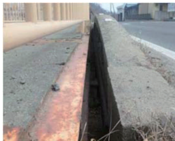
(b) 道路橋(右)との隙間(桁下)
