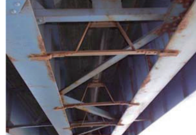
(f) 添架物の取付金具の腐食
