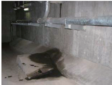
(e) 箱桁内の排水管からの漏水
