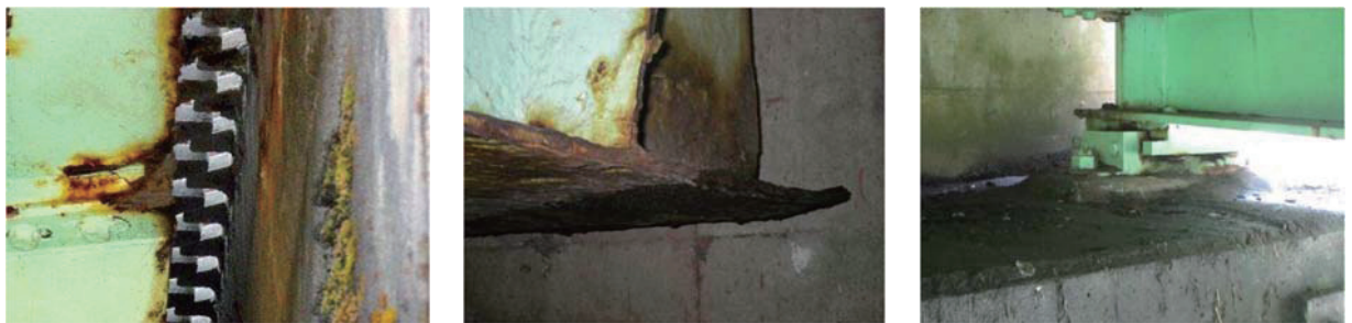
(a) A1直上の伸縮装置(排水) (b) A1側の主桁端部の腐食状況 (c) A2側の主桁端部の腐食状況
