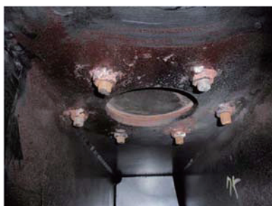
(g) 作業孔蓋からの漏水
