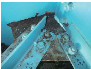
(a) ガセットの滞水・土砂堆積
