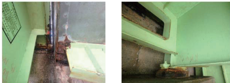
(a) 桁端部の道路橋との隙間 (b) 桁端部の支承の腐食
