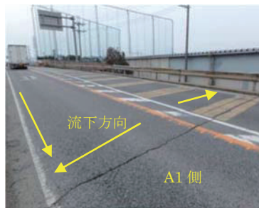
(a) A1側の橋面排水の流下方向
