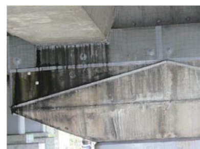
(i) 橋脚の水切りの設置
