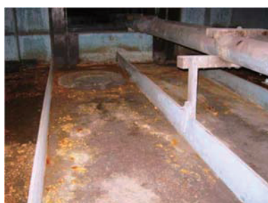
(b) 排水不良による腐食
