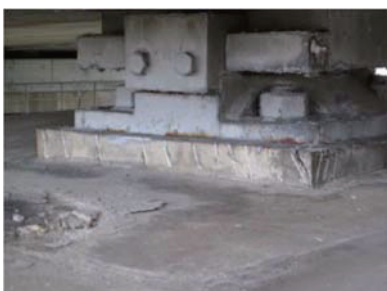
(d) 沓座モルタルのひびわれ
