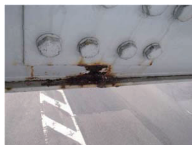
(i) 部材境界部の腐食
