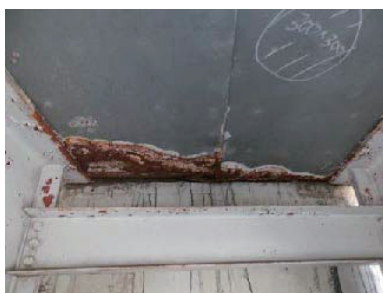
(b) 桁端部の防水不良
