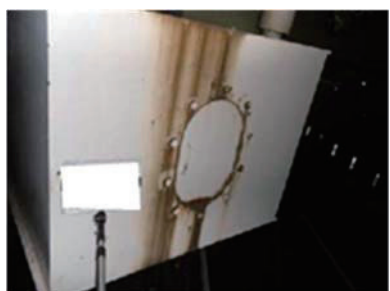
(d) 伝い水によるボルトの腐食
