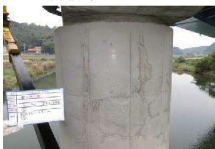
(d) RC 巻き立て部のひびわれ
