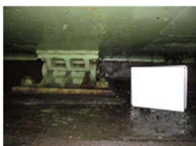
(a) 滞水による支承本体の腐食
