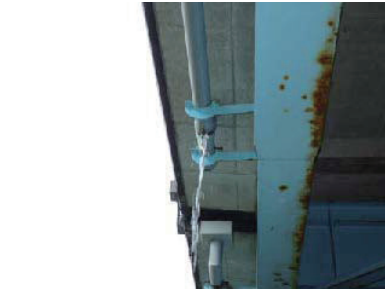
(e) 排水管の破損
