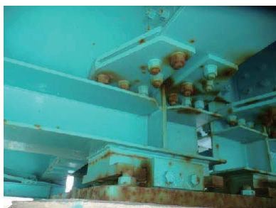
(g) 支承周辺の部材取り合い部
