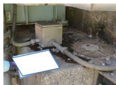
(f) 橋座面の土砂だまり
