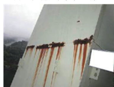
(i) 主塔の溶接部の滞水
