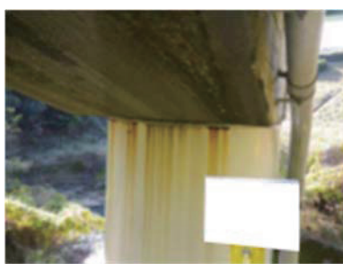
(b) 梁部下面からの伝い水
