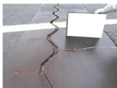
(d) 後打ちコンクリートのひびわれ
