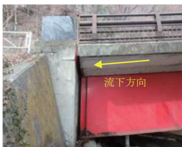
(a) A2側の主桁側面状況
