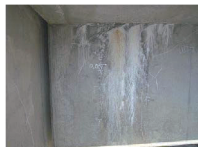
(f) 桁端部の遊離石灰を伴うひびわれ
