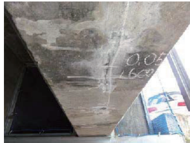
(h) PC 桁下面のひびわれ
