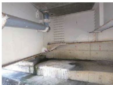
(g) 排水管の損傷
