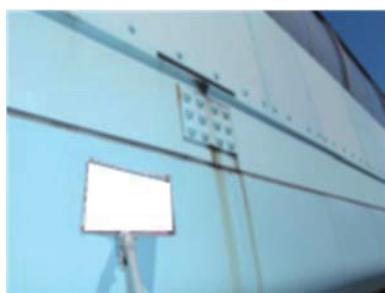
(g) 部材境界部からの漏水
