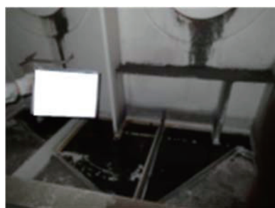
(d) マンホール付近の滞水
