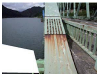
(a) 添接板下端部に滞水
