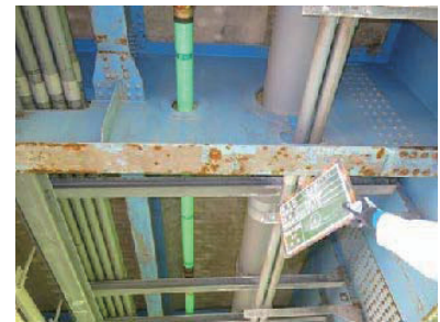
(f) 添架管位置の配慮不足
