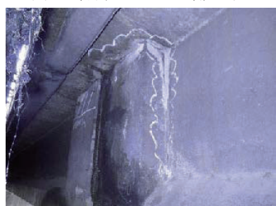
(d) 定着部の境界部から漏水
