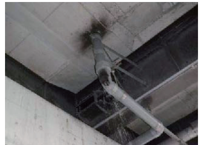
(c) 排水管の取り付け部から漏水
