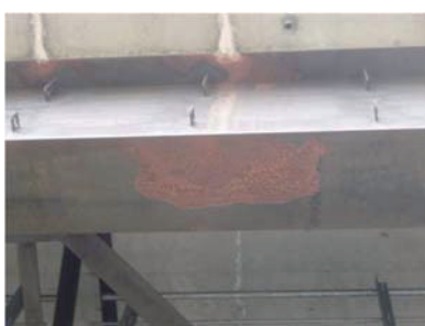
(b) 床版漏水箇所からの伝い水
