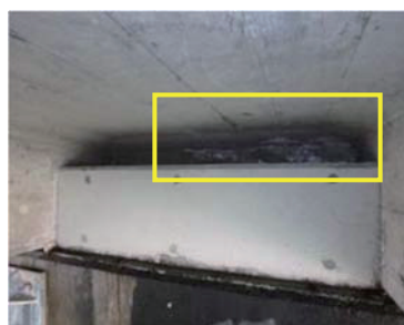
(a) A1側の堅壁前面の漏水
