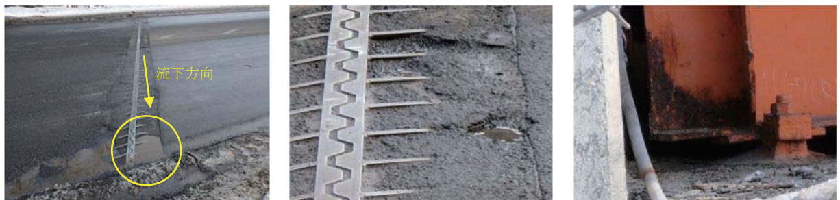
(a) A1 側の伸縮装置端部の滞水
