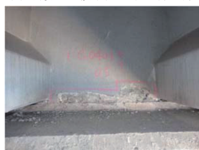
(g) 横桁底部の剥離
