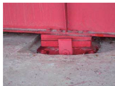
(c) 橋座を切り欠いて設置
