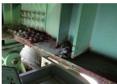
(a) 横桁下フランジ部の滞水
