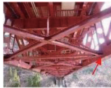
(e) トラス下弦材の確認困難
