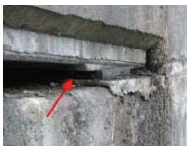
(b) 桁下面と橋座の離隔が狭い
