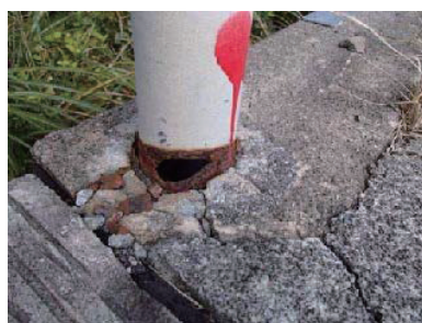
(e) 防護柵基部の腐食
