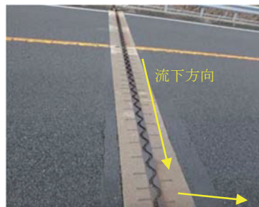
(a) A2側の伸縮装置 (G1桁側に流下)
