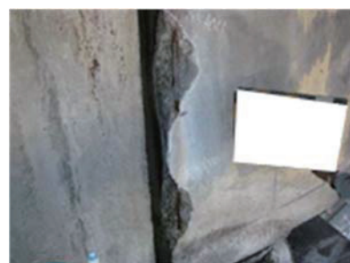
(j) 主桁端部の鉄筋露出
