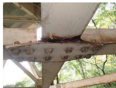
(i) 下横構の腐食
