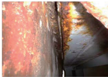
(b) A1側の伸縮装置下面の腐食
