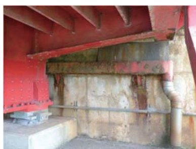
(h) 排水樋の腐食
