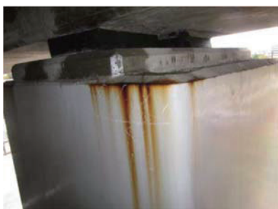
(a) 鋼板巻立ての上端部の滞水
