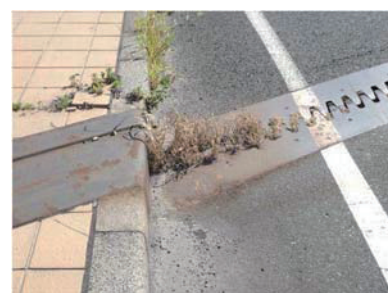
(c) 遊間部の土砂詰まり
