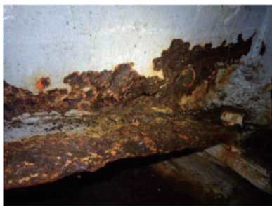
(a) A2 側の主桁端部の腐食
