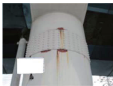
(c) 添接部付近の塗膜の水膨れ
