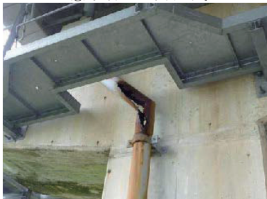
(j) 排水管屈曲部の腐食
