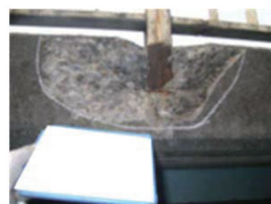
(f) 支柱基部の地覆の剥離
