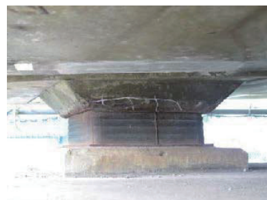
(f) レア一部のひびわれ
