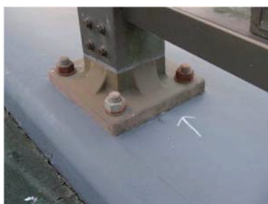
(h) 支柱基部のボルトの腐食
