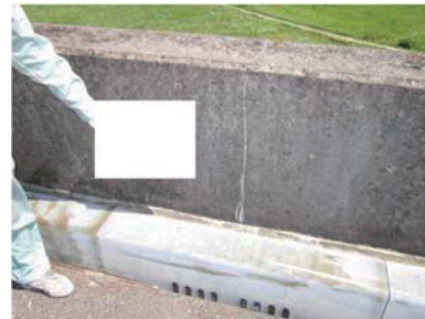
(h) 集水枡の取り付け
