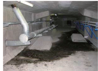
(f) 箱桁内の排水不良
