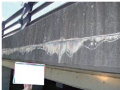
(d) 地覆継ぎ目部の遊離石灰
