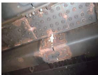
(h) 部材境界部の腐食
