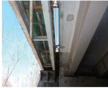
(b) 道路橋(右)との隙間(桁下)
