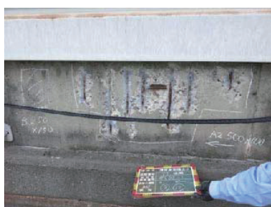
(a) 壁高欄の鉄筋露出
