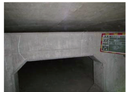
(c) 横桁ハンチ部のひびわれ
