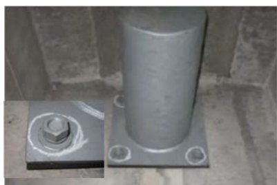
(d) ボルトの突出不足
