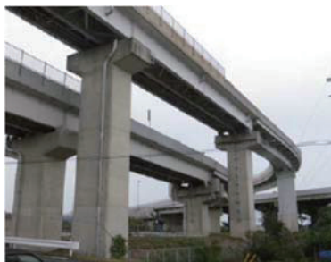
(b) 検査路の未設置
