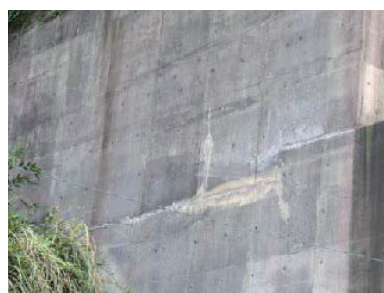
(h) 橋台側面からの漏水
