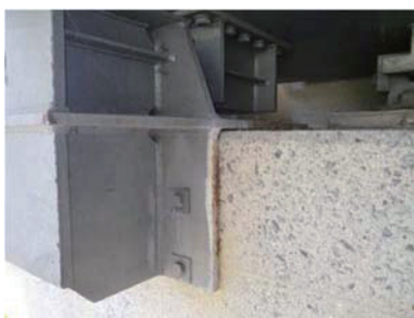
(h) 落橋防止システムと下部構造との取り合い
