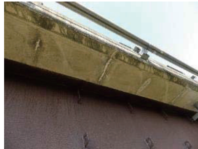
(b) 床版ひびわれから遊離石灰
