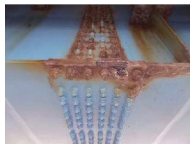
(c) 桁下フランジからの伝い水
