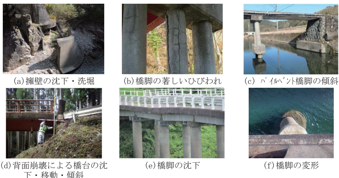
写真-3.2.2 突発的事象由来の損傷例
