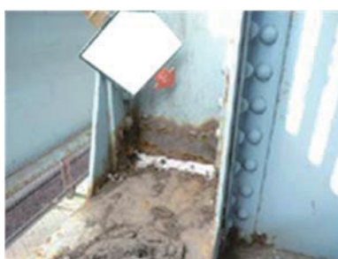
(e) 垂直材基部の腐食
