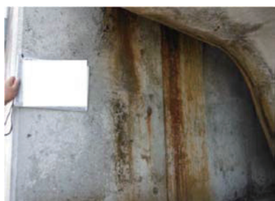
(a) 伸縮装置からの伝い水
