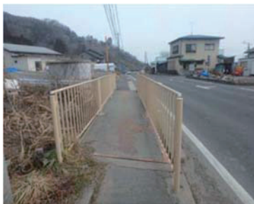
(a) 橋面全景
