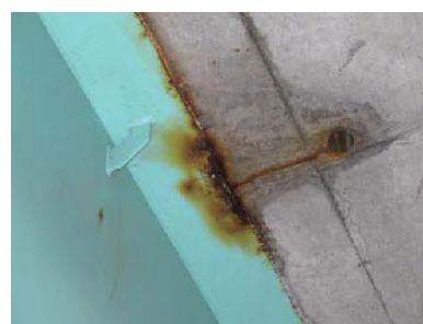
(c) 水抜き孔からの排水
