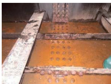
(a) 箱桁内の排水不全
