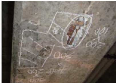
(g) PC 桁下面の鉄筋露出
