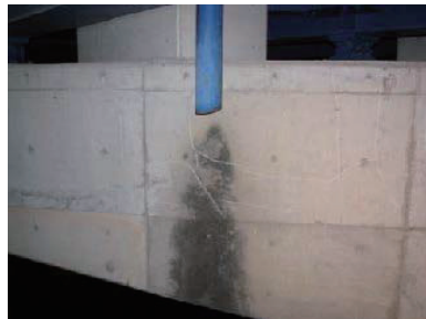
(b) 排水管からの排水の飛散
