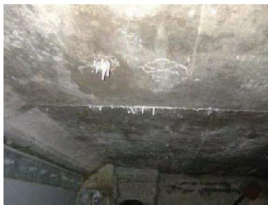
(b) 打ち継ぎ目の遊離石灰
