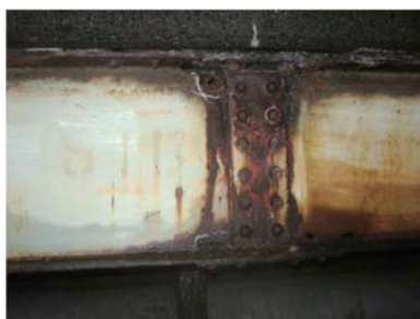
(d) 添接板の腐食
