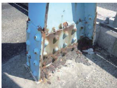
(d) 垂直材埋め込み部の腐食
