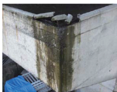
(a) 橋脚上漏水処理
