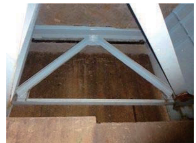
(c) A1 側の桁下の腐食・漏水
