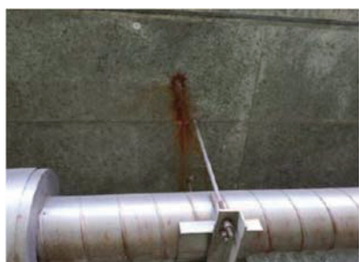
(a) 取付金具の腐食
