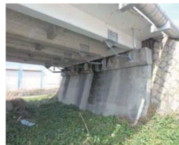
(b) A1 堅壁前面の漏水
