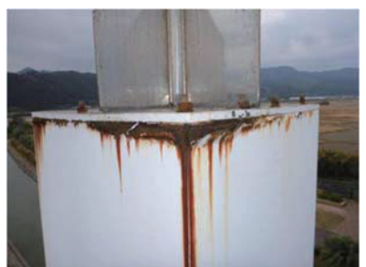
(g) 照明柱台座の腐食
