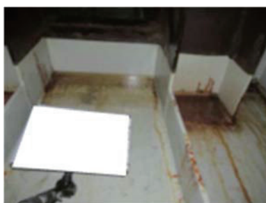
(e) 鋼製橋脚梁部の滞水
