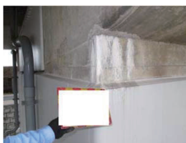
(b) 継ぎ目からの漏水
