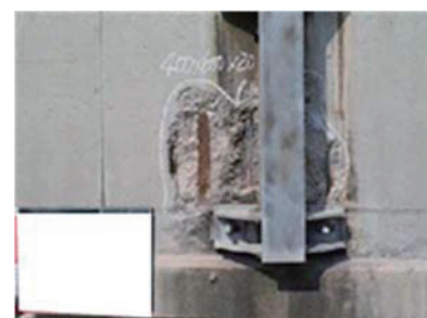
(i) 壁高欄の鉄筋露出
