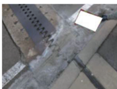
(b) 橋面の土砂堆積
