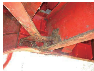
(c) 横桁と下横構との接合部
