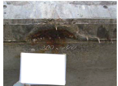
(c) 地覆側面からの伝い水
