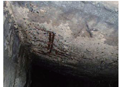
(i) RC 床版桁下面の鉄筋露出
