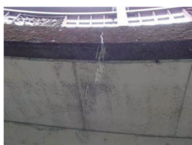
(a) 床版と地覆下面の取り合い部
