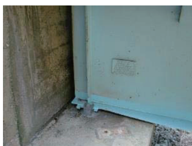
(a) 桁端部と胸壁の離隔が狭い
