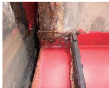
(b) A2側の外桁上フランジの腐食
