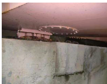
(h) マンホールが開けない
