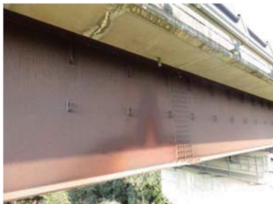
(a) 水抜き孔からの排水の飛散
