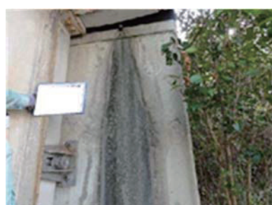
(g) 水抜き孔からの伝い水
