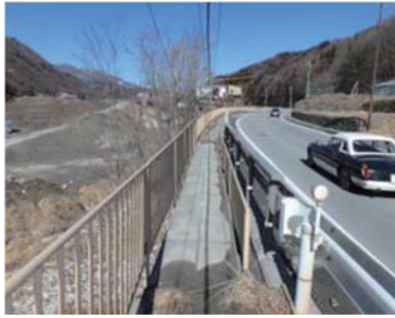
(a) 橋面全景
