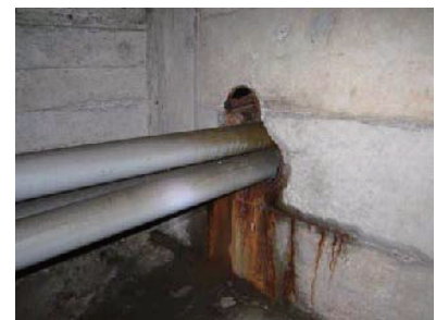
(i) 添架管接続部からの漏水
