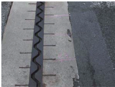
(a) A1側の伸縮装置の後打ちコンクリートのひびわれ*
