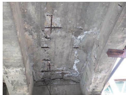
(d) 鉄筋のかぶり不足
