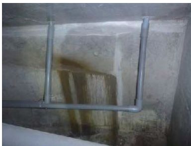
(a) 側面のひびわれ部に漏水跡
