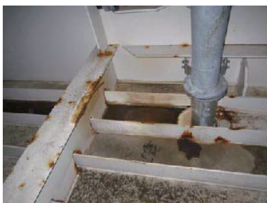
(h) 排水管付近の滞水
