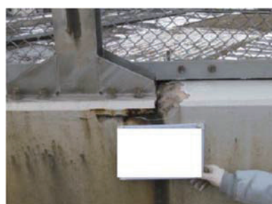
(c) 壁高欄目地付近の鉄筋露出
