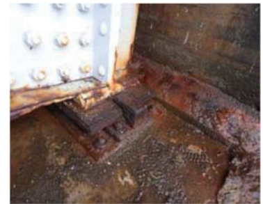
(c) 主桁端部の腐食
