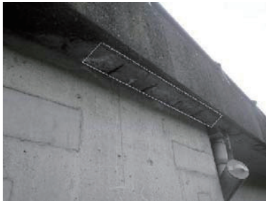
(a) 床版下面の鉄筋露出
