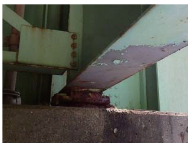
(e) 主桁側面からの伝い水
