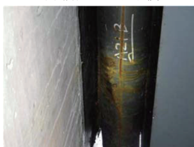
(e) 止水材からの漏水
