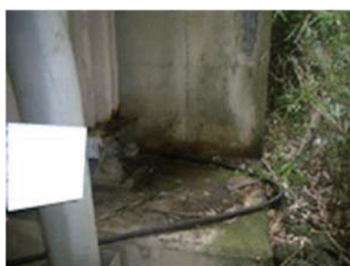
(h) 橋台側面からの土砂流入
