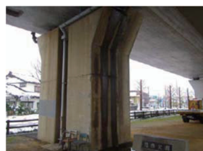
(c) 伸縮装置からの伝い水
