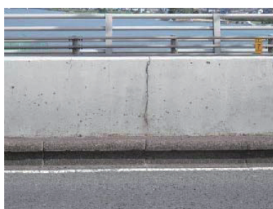
(b) 壁高欄のひびわれ
