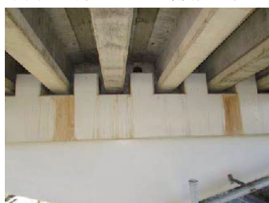
(d) 桁端部の進入困難
