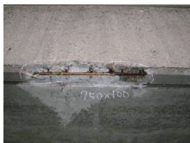
(g) 水切り近傍の鉄筋露出
