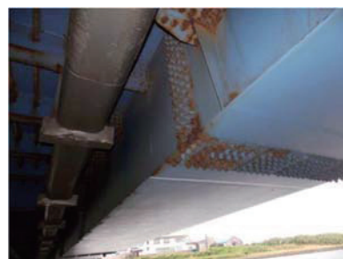
(f) 添接板の腐食
