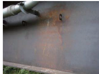
(k) 伝い水による主桁の腐食
