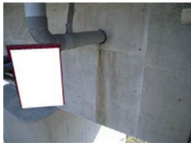
(d) 箱桁との取り付け部
