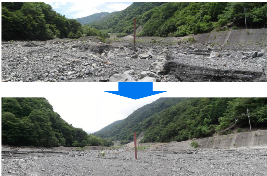
図 4 大規模土砂生産後の河床の状況
