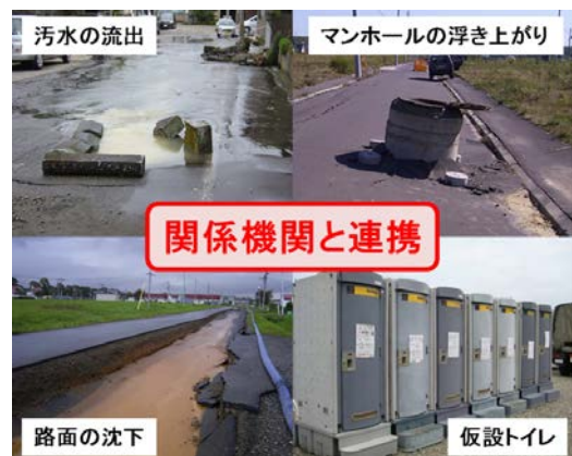
写真-1 下水道施設被災時の例
