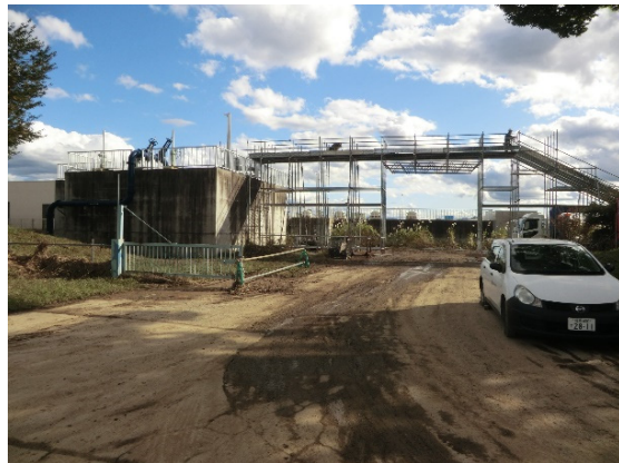
写真-4.6 仮設管の設置状況（分配槽）
