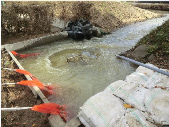
写真-4.3 場内人孔での溢水、消毒状況
