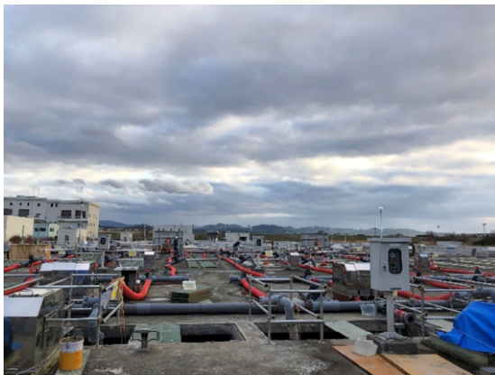
写真-4.8 最初沈殿池分配層仮設状況
