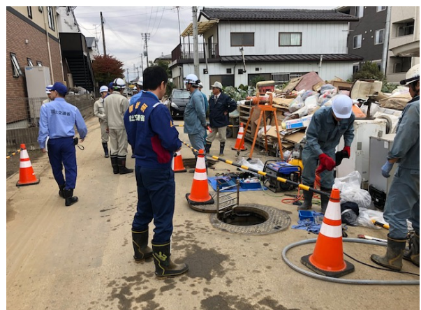
写真-4.18 真空式下水道被害状況確認
