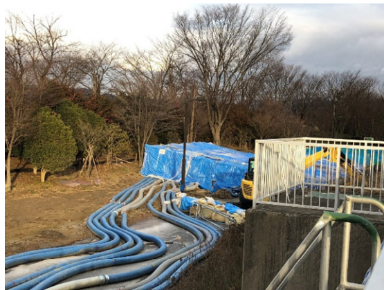
写真-4.7 流入水仮設揚水ポンプ設置状況
