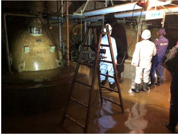
写真-4.15 雨水ポンプ場被害状況確認
