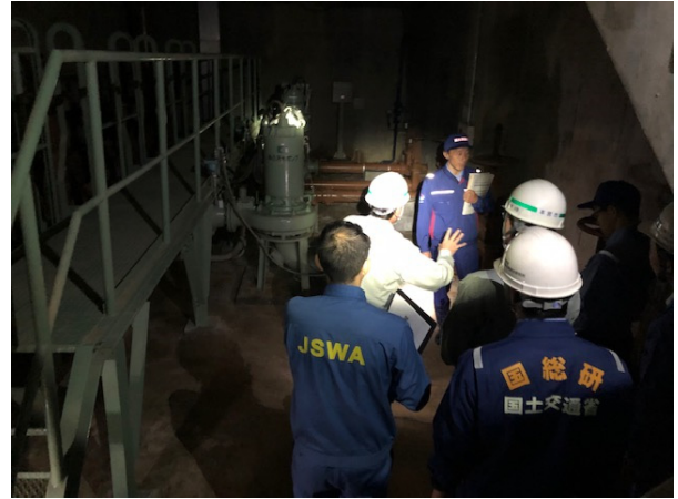
写真-4.16 汚水ポンプ場被害状況確認
