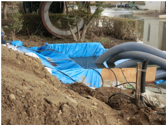
写真-4.5 揚水仮設ポンプの設置状況
