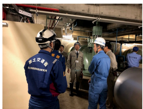
写真-4.20 雨水ポンプ場被害状況確認
