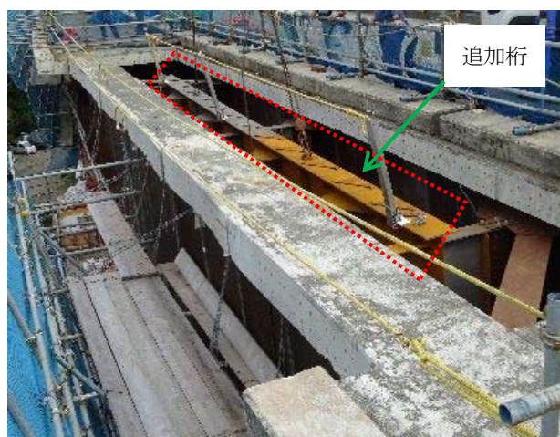
補強材片の設置状況
