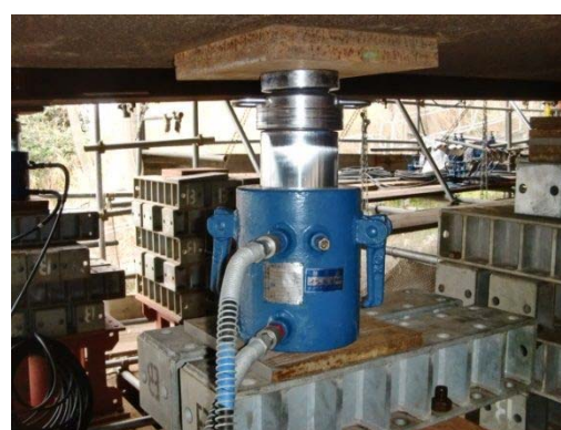
写-4.1.2 油圧ジャッキ（加圧ジャッキ、受けジャッキ）
