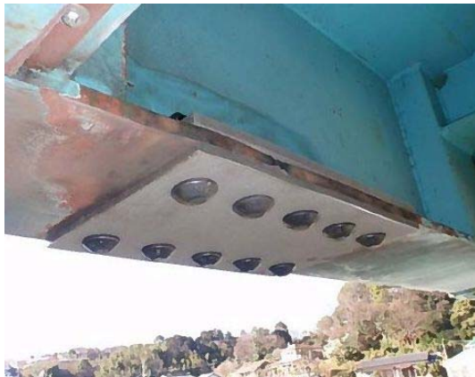
加熱矯正後（当て板施工後）
