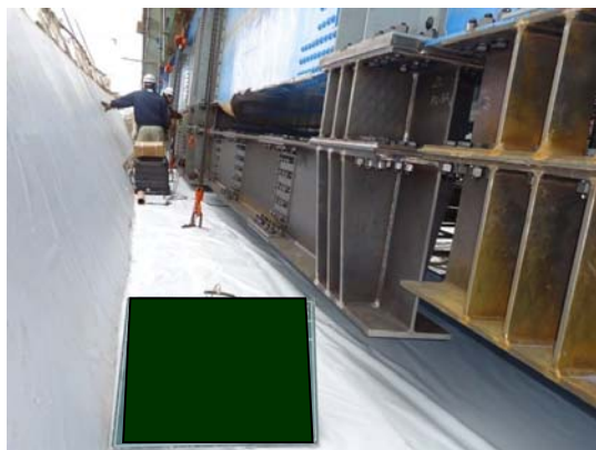
バイパス部材設置状況
