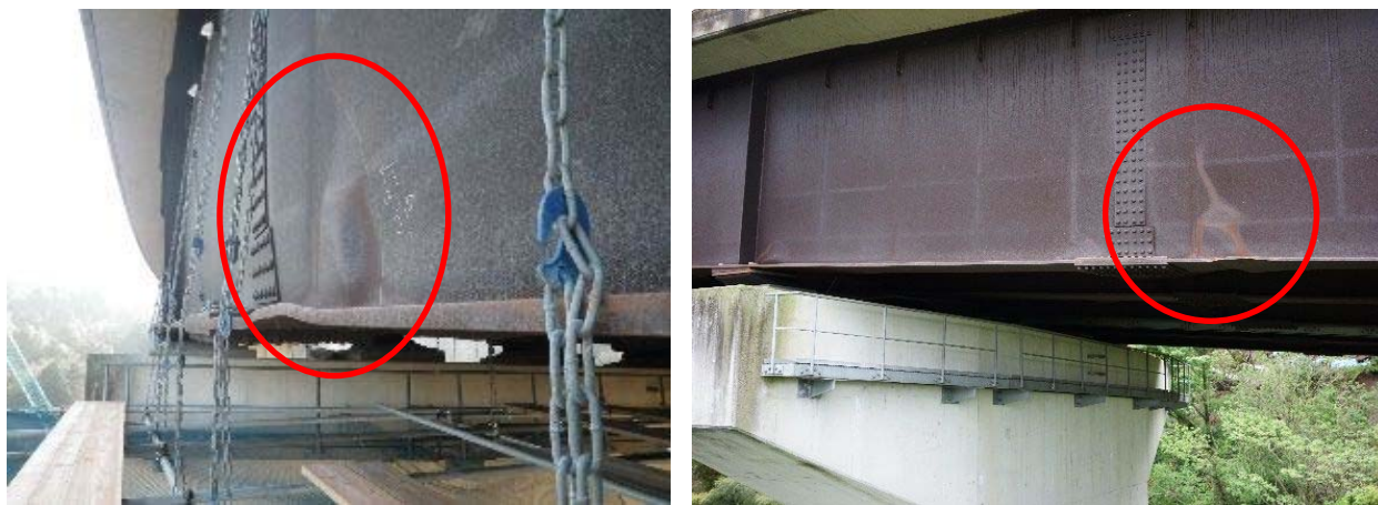
ウェブ、下フランジの変形状況
