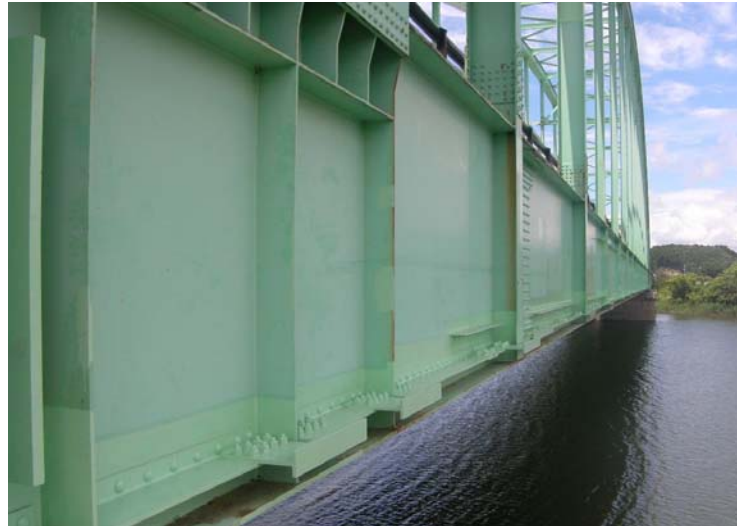
参-写真-3.1.6 下フランジ腐食欠損部の断面補填を目的とした補強工の完成状
