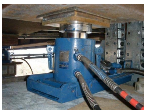
写-4.1.2 油圧ジャッキ（加圧ジャッキ、受けジャッキ）
