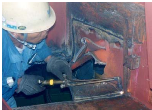
切断・撤去状況
