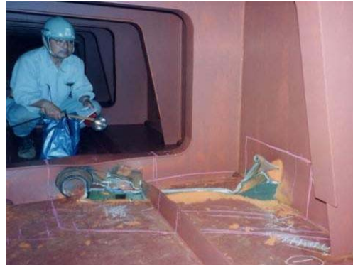
損傷状況（内面）
