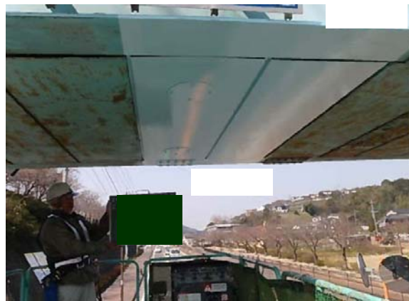
補修完了状況
