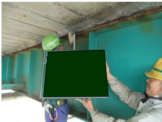
上フランジ腐食状況
