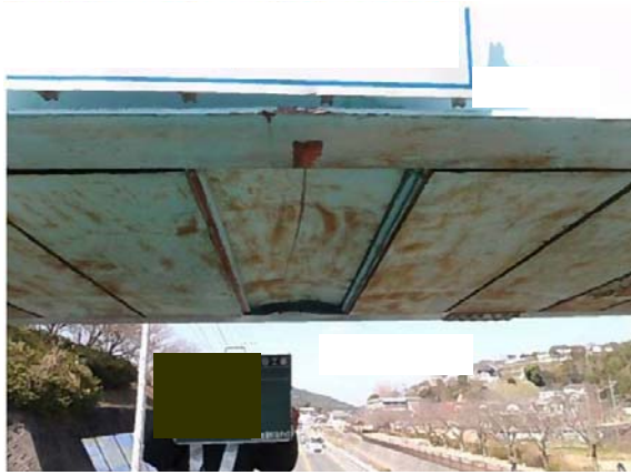
損傷状況（化粧パネル有）
