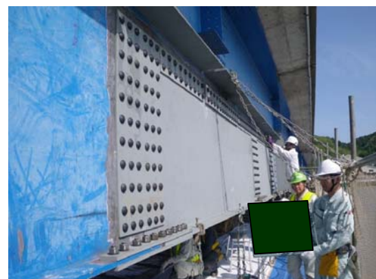
材片の取替完了状況
